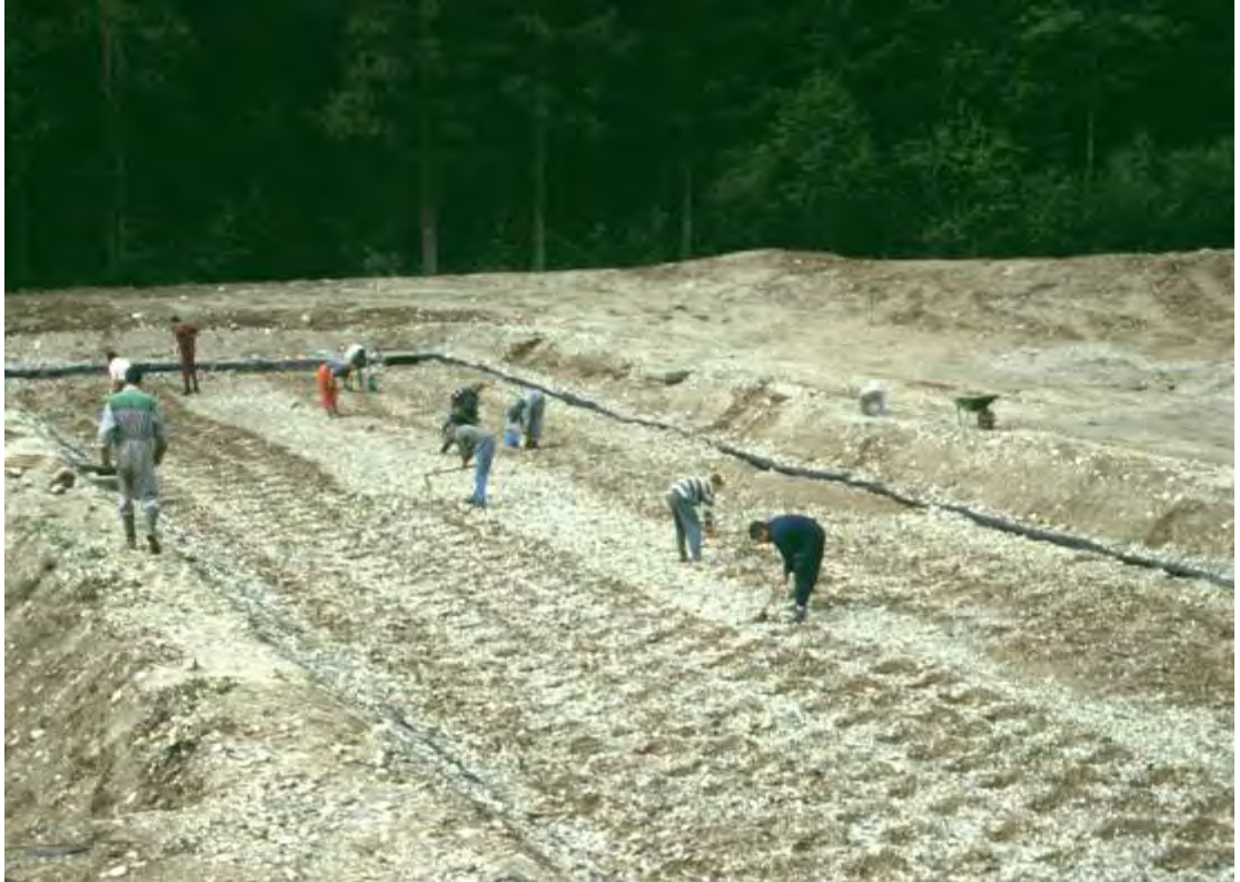
Εικόνα 39. Κατασκευή τεχνητού υγρότοπου.
