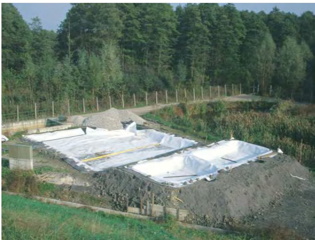
Εικόνα 26. Κατασκευή τεχνητού υγρότοπου Λίμνη Πλαστήρα
