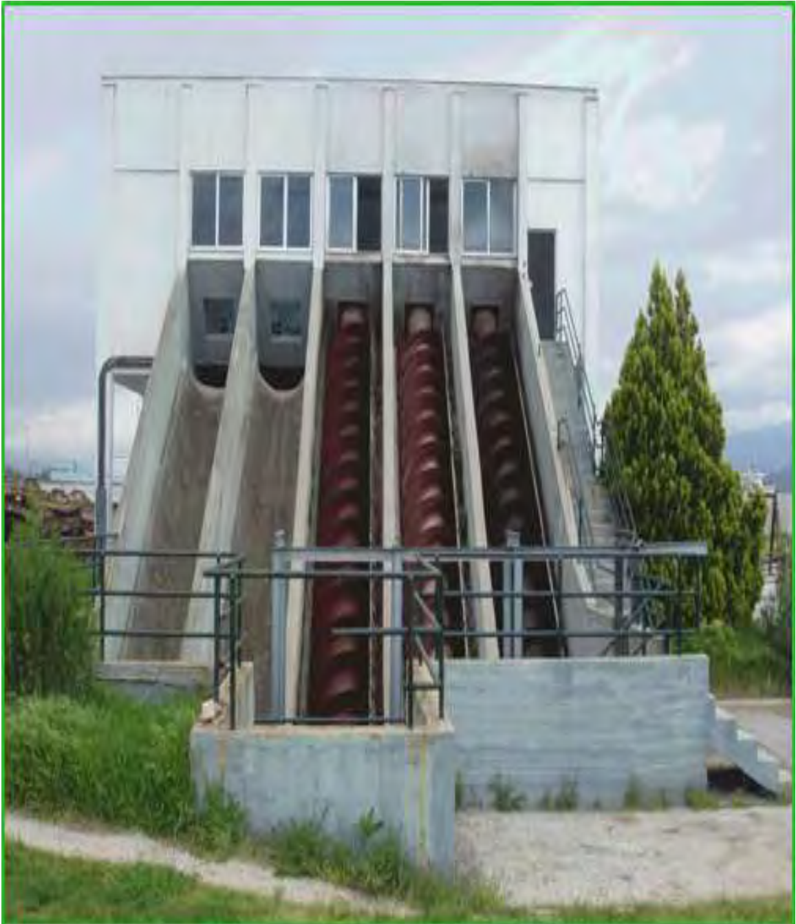
Εικόνα 4. Αντλιοστάσιο Ανύψωσης
