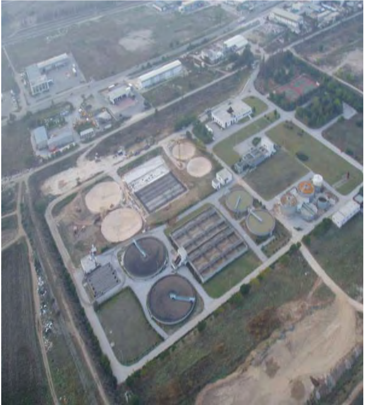
Εικόνα 14. Εγκατάσταση Επεξεργασίας Αστικών Λυμάτων Λάρισας
