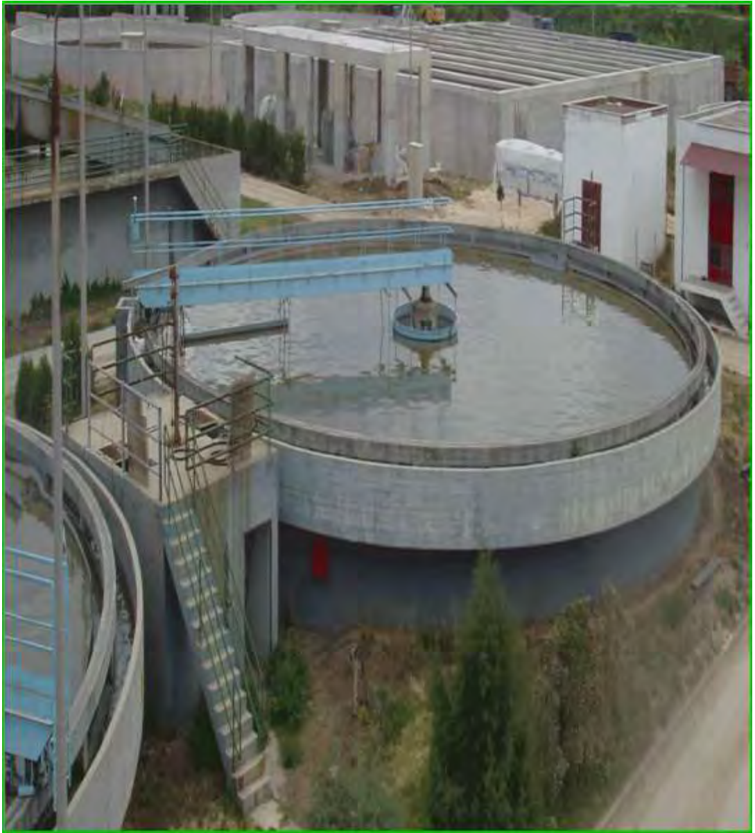
Εικόνα 7. Δεξαμενή Πρωτοβάθμιας Καθίζησης
