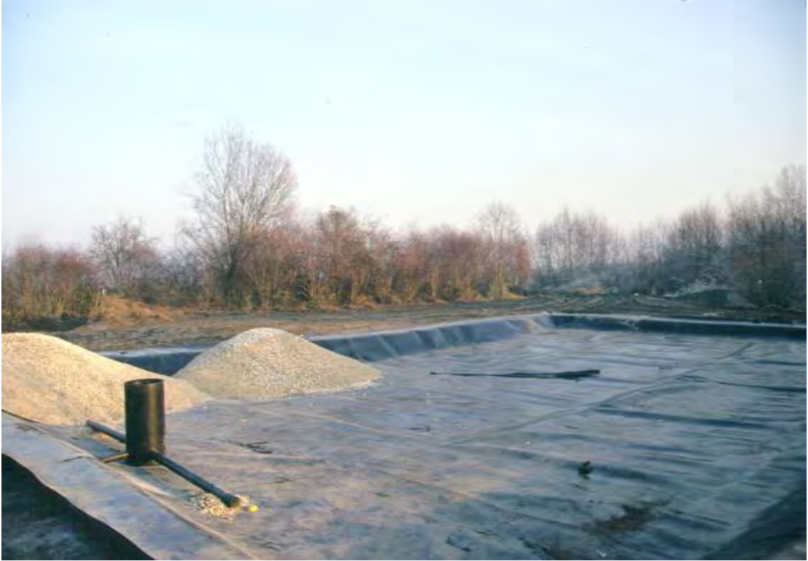
Εικόνα 27. Κατασκευή τεχνητού υγρότοπου Λίμνη Πλαστήρα
