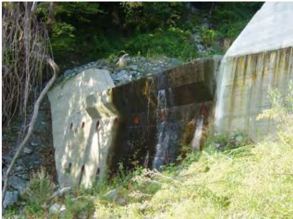
Εικόνα 83: Κατάντη του φράγματος Νο 5
