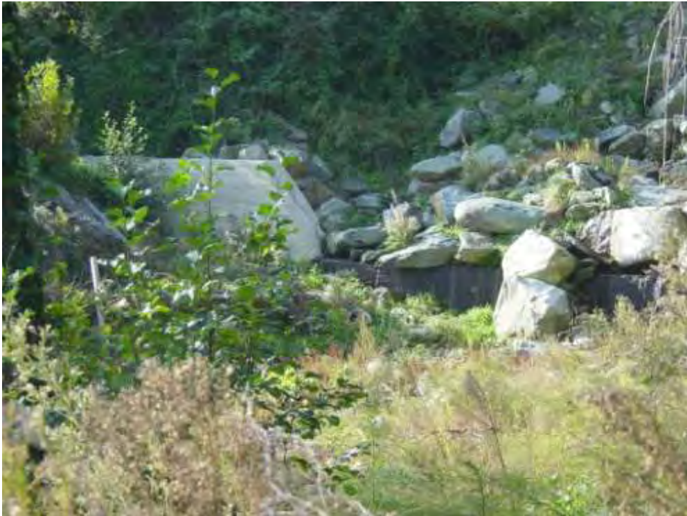
Εικόνα 88: Καπάνη του φράγματος Νο 8
