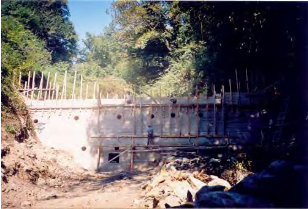
Εικόνα 80: Κατά τη διάρκεια των εργασιών του φράγματος Νο 4
