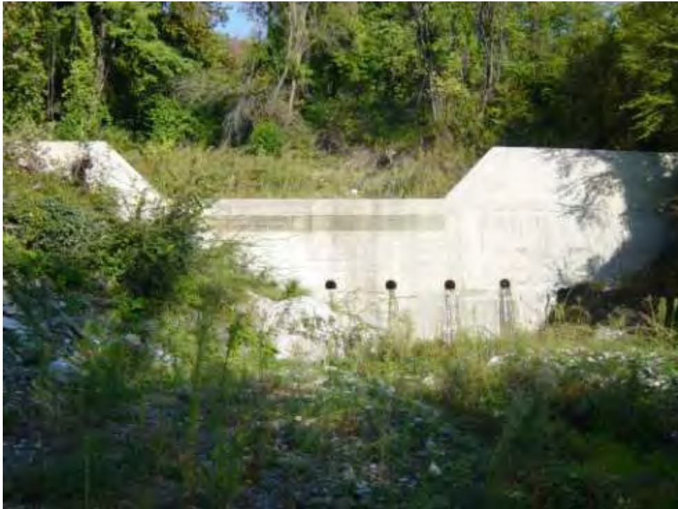
Εικόνα 84: Καπάντη του φράγματος Νο 6
