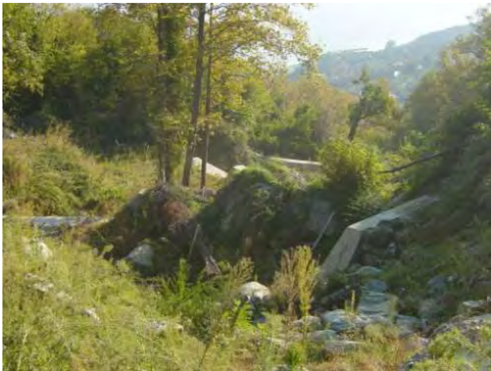
Εικόνα 81: Ανάντη των φραγμάτων Νο 5, 6, 7, 8
