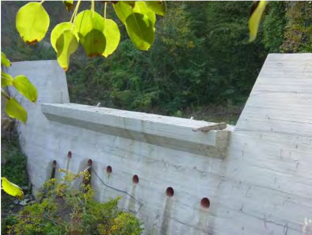
Εικόνα 100: Καπάνη του φράγματος Νο 15
