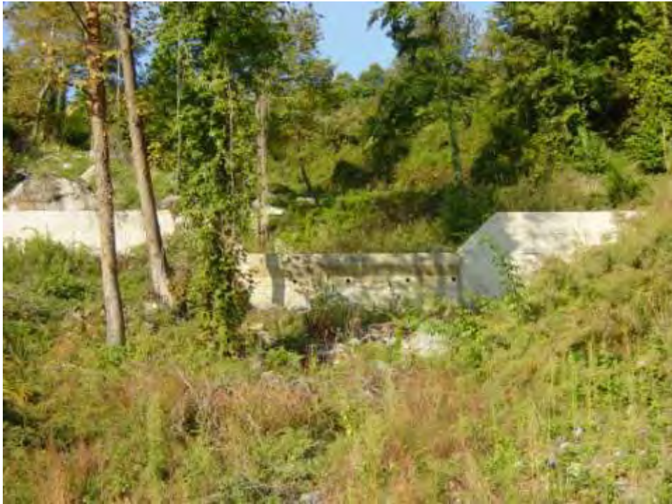
Εικόνα 86: Κατάντη του φράγματος Νο 7
