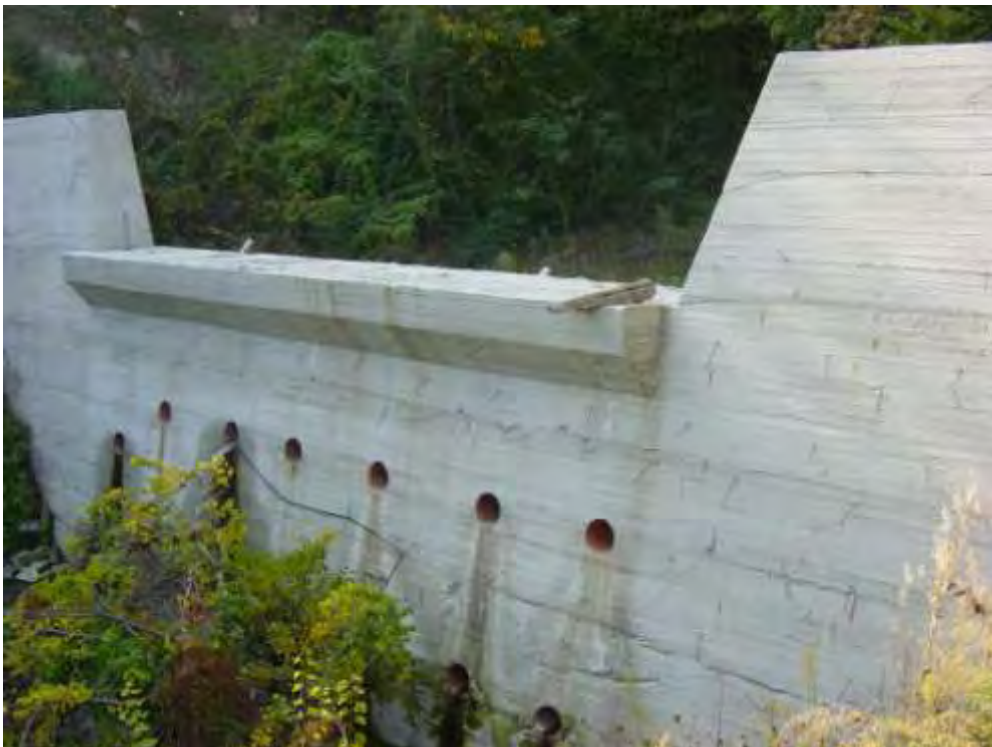
Εικόνα 99: Κατάληξη του φράγματος Νο 15
