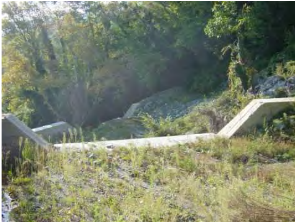
Εικόνα 85: Ανάντη των φραγμάτων Νο 6, 7
