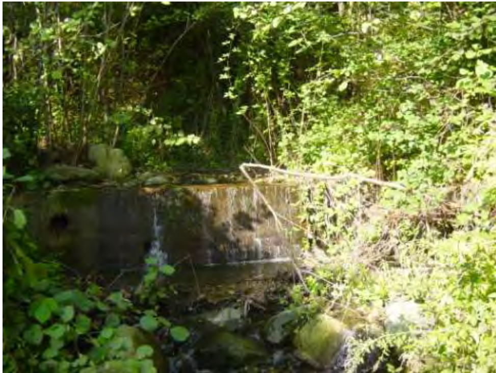
Εικόνα 91: Κατάντη του φράγματος Νο 10
