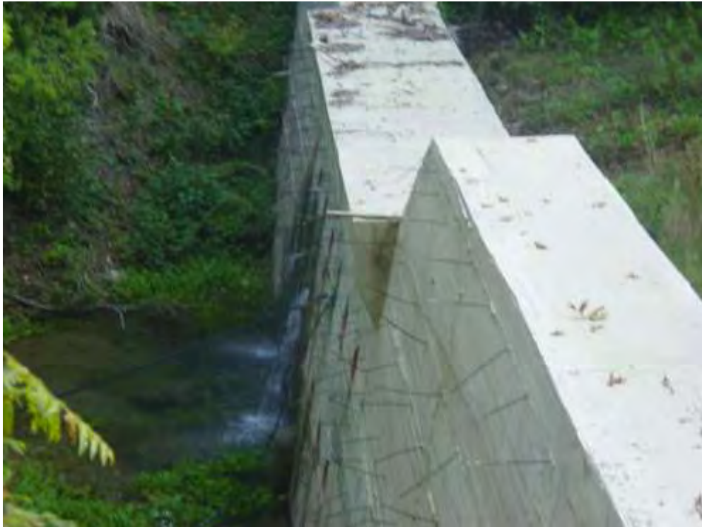
Εικόνα 102: Κατάντη του φράγματος Νο 16
