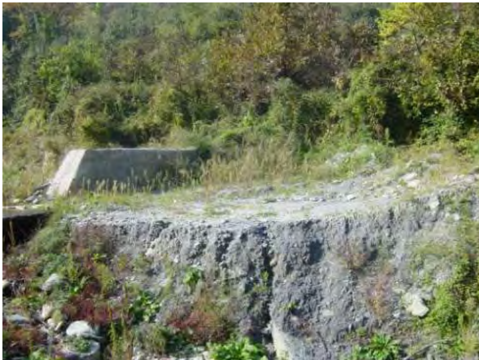
Εικόνα 93: Ανάντη του φράγματος Νο 12
