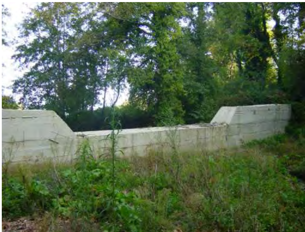
Εικόνα 104: Ανάντη του φράγματος Νο 16
