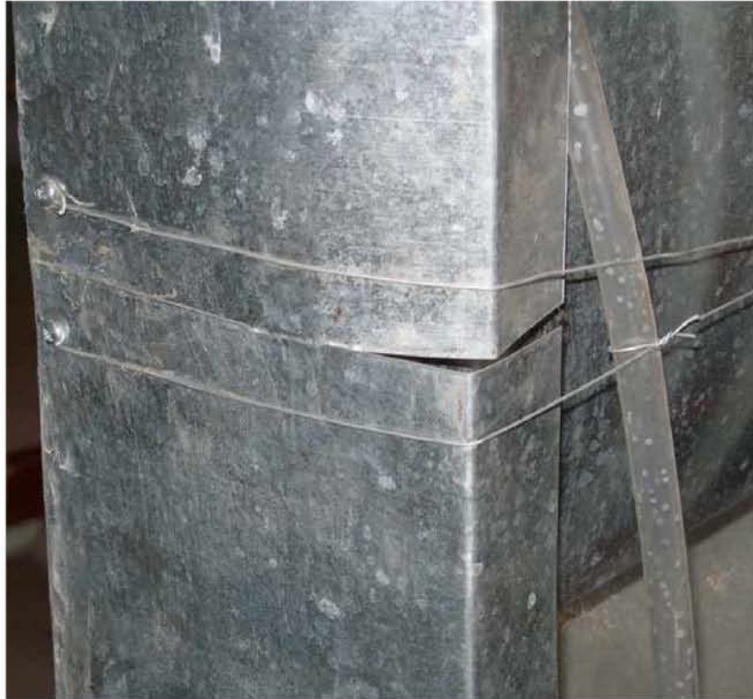
Εικόνα 11. Συγκράτηση και τάνυση των λαμαρινών με περτσίνια και σύρμα επί του πλαισίου.
