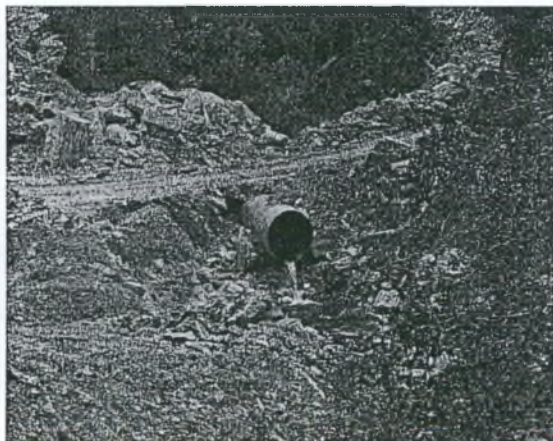
Φωτο 5.1: Αγωγός εκτροπής κατάντη
