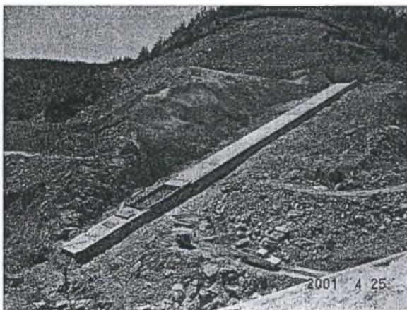
Φωτο 5.5: Σκυροδέτηση πλίνθου
