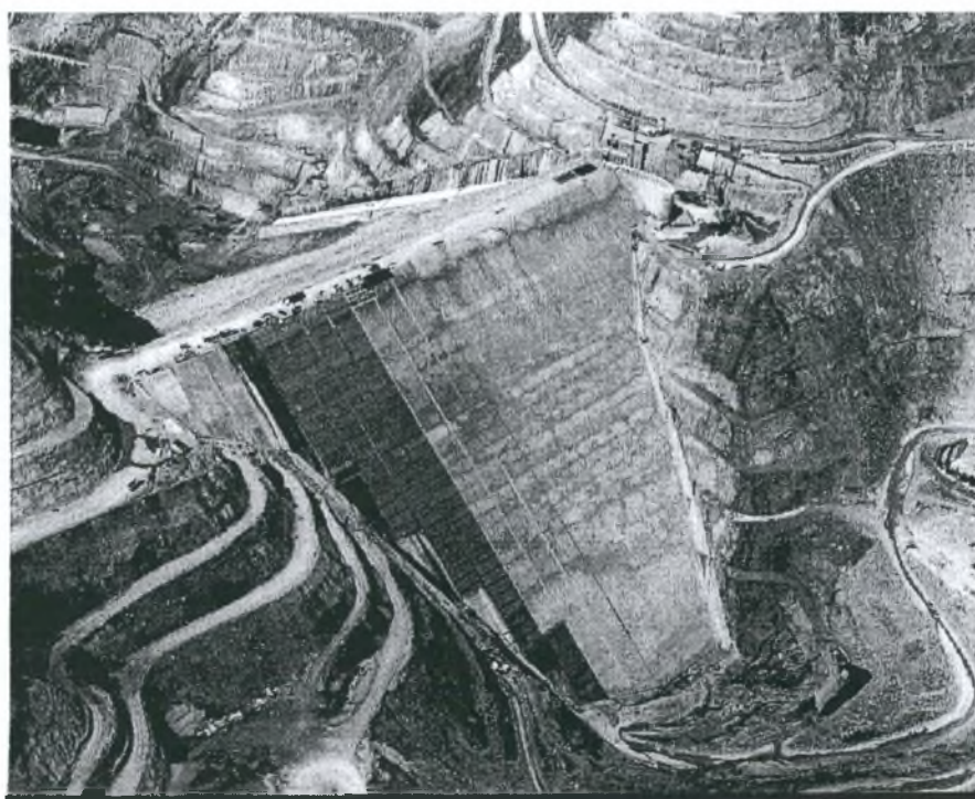
Φωτογραφία 2: Φράγμα Μεσοχώρας κατά την διάρκεια κατασκευής του
