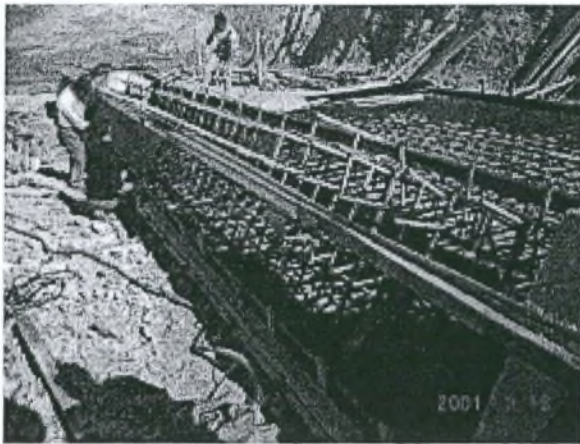
Φωτο 5.7: Τοποθέτηση water stop
