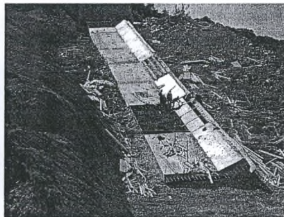
Φωτο 5.6: Σκυροδέτηση πλίνθου
