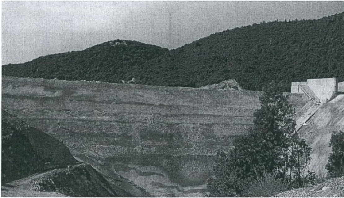
Φωτογραφία 1: Φράγμα Παναγιώτικο κατά την ολοκλήρωση του αναχώματος
