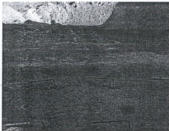
Φωτο 5.4: Ραβδοι αγκύρωσης
