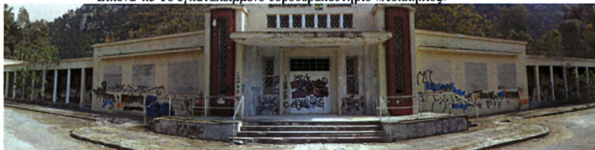
Εικόνα 4.5 Το εγκαταλειμμένο υδροθεραπευτήριο «Ασκληπιός»
