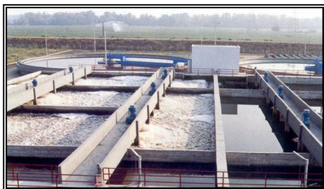
Σχήμα 2.2: Παράδειγμα δευτεροβάθμιας δεξαμενής αερισμού
