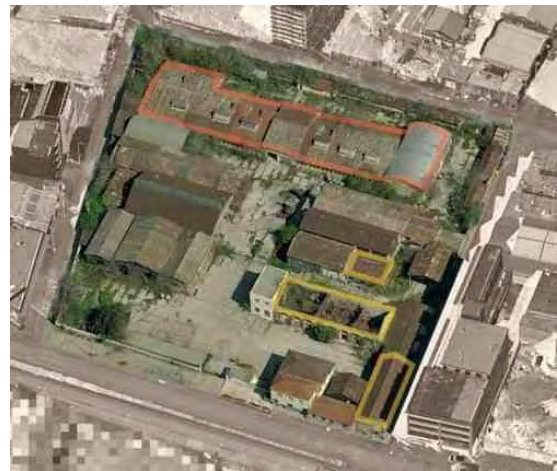
Εικόνα 20: Το Παλιό Εργοστάσιο Παραγωγής Φωταερίου
