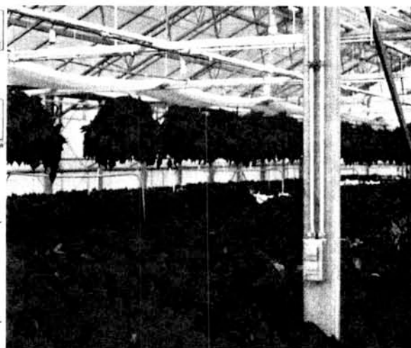
Σχήμα 1.5 – Εναέριοι σωλήνες θέρμανσης θερμοκηπίου
