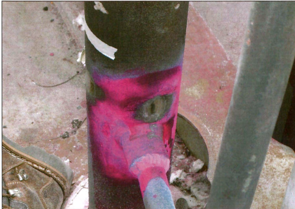
Εικόνα 3.3: Έλεγχος αυλού με διεισδυτικά υγρά
