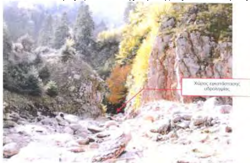
Εικόνα 6.2: Χώρος εγκατάστασης υδροληψίας ΜΥΗΣ Καρυάς
