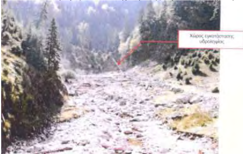
Εικόνα 6.1: Χώρος εγκατάστασης υδροληψίας ΜΥΗΣ Καρυάς
