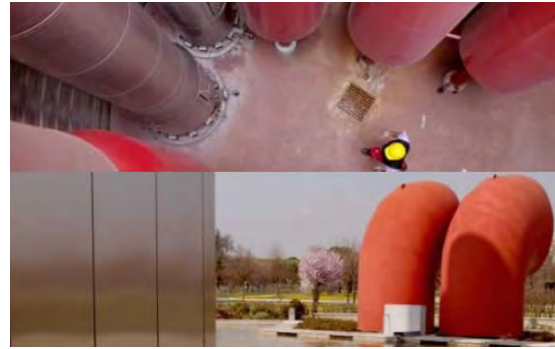
Εικόνα 23: Η κεντρική μονάδα θέρμανσης στην Ίμολα (Πηγή: Lavagno and Schranz, 2007)
