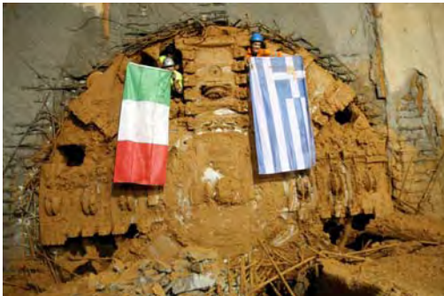
Εικόνα 71: Φάση κατασκευής του Μετρό της Θεσσαλονίκης (Πηγή: Αττικό Μετρό ΑΕ)
