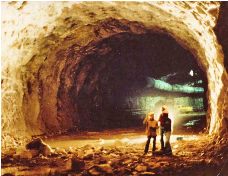
Εικόνα 11: Φάση κατασκευής της σήραγγας προσαγωγής του υπόγειου ΥΗΣ του Ρίο Γκράντε (Πηγή: Hoek, 2006)
