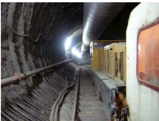
Εικόνα 65: Φάση κατασκευής της σήραγγας εκτροπής του Αχελώου (Πηγή: Προσωπικό αρχείο)
