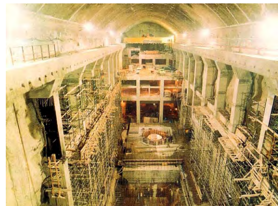
Εικόνα 66: Φάση κατασκευής του υπόγειου ΥΗΣ του φράγματος Θησαυρού στο Νέστο (Πηγή: Μαυρίκος, 2006)
