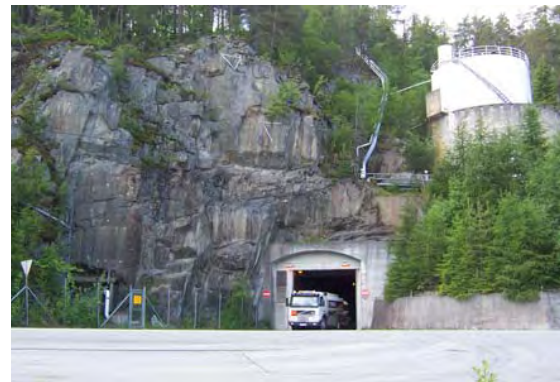
Εικόνα 25: Μεταφορά πετρελαίου από υπόγειο θάλαμο αποθήκευσης στο Τρόντχαϊμ (Πηγή: Broch, 2007)
