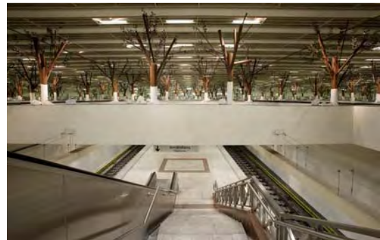
Εικόνα 58: «Υπόγειο Πάρκο», έργο στο Μετρό της Αθήνας (Πηγή: Αττικό Μετρό ΑΕ)
