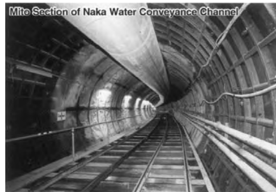
Εικόνα 10: Η σήραγγα μεταφοράς νερού στην περιοχή του ποταμού Naka (Πηγή: Nordmark, 2002)
