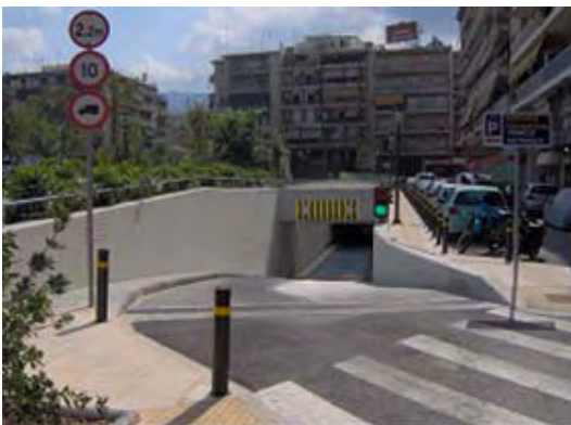
Εικόνα 69: Η είσοδος του υπόγειου χώρου στάθμευσης στο Νοσοκομείο Παιδών της Αθήνας (Πηγή: Pappa and Benardos, 2007)
