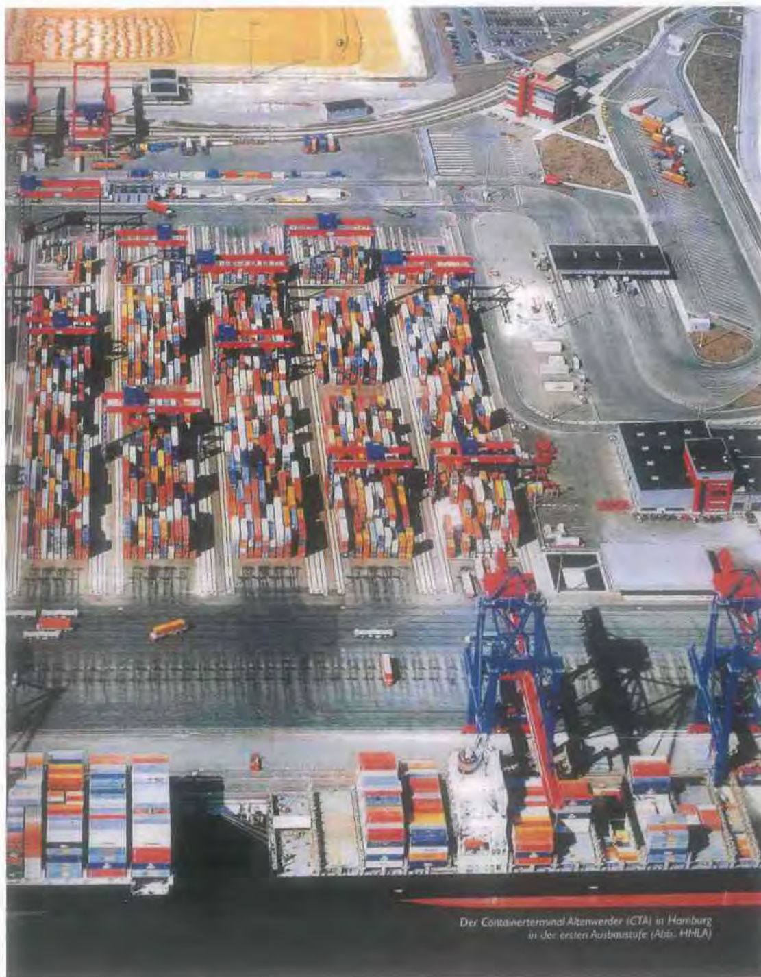
Εικόνα 21 ΣΕΜΠΟ Altenwerder (CTA) στο Αμβούργο (Hamburg –DEUTSCHLAND)
