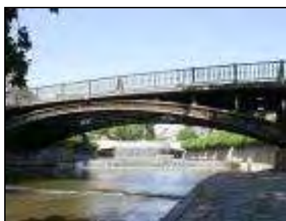
Εικόνα 3.5: Κεντρική γέφυρα Ληθαίου ποταμού
