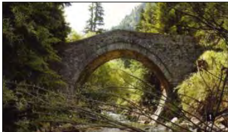
Εικόνα 4.6: Γέφυρα Γκίκα (Κρασιά)
