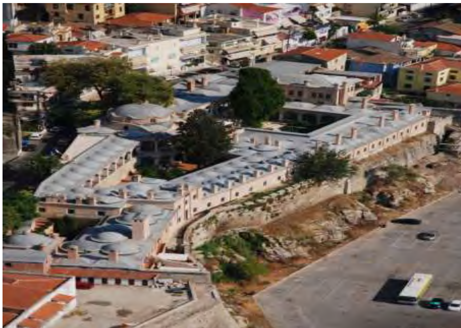
Αεροφωτογραφία του Ιμαρέτ (Αύγουστος 2007)
