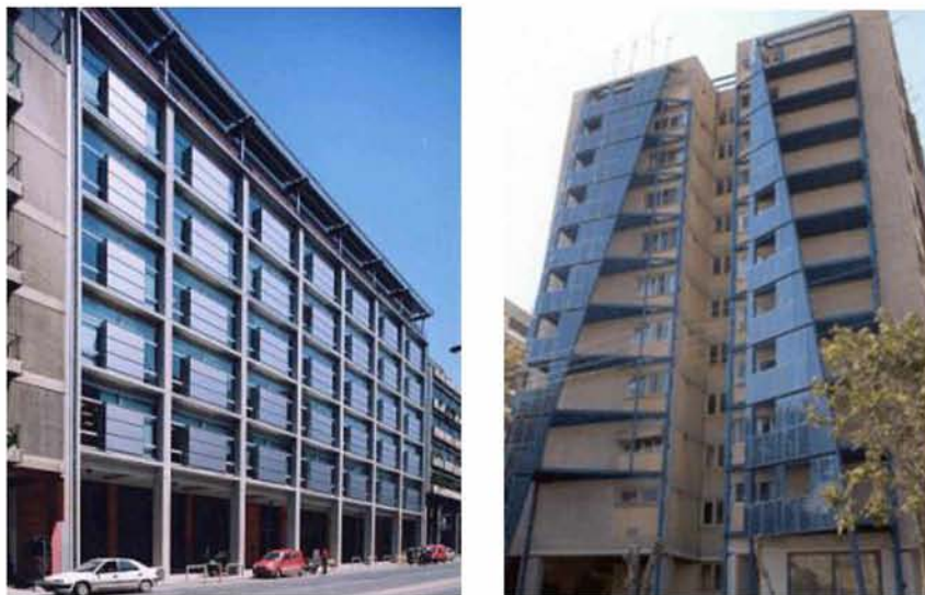
Εικόνα 34 : Ενσωμάτωση Φ/Β σε προσόψεις κτιρίων, κτίριο γραφείων της εταιρείας ΓΕΚ-ΤΕΡΝΑ στην οδό Μεσογείων - Αθήνα και κτίριο πολυκατοικιών στον Ταύρο
