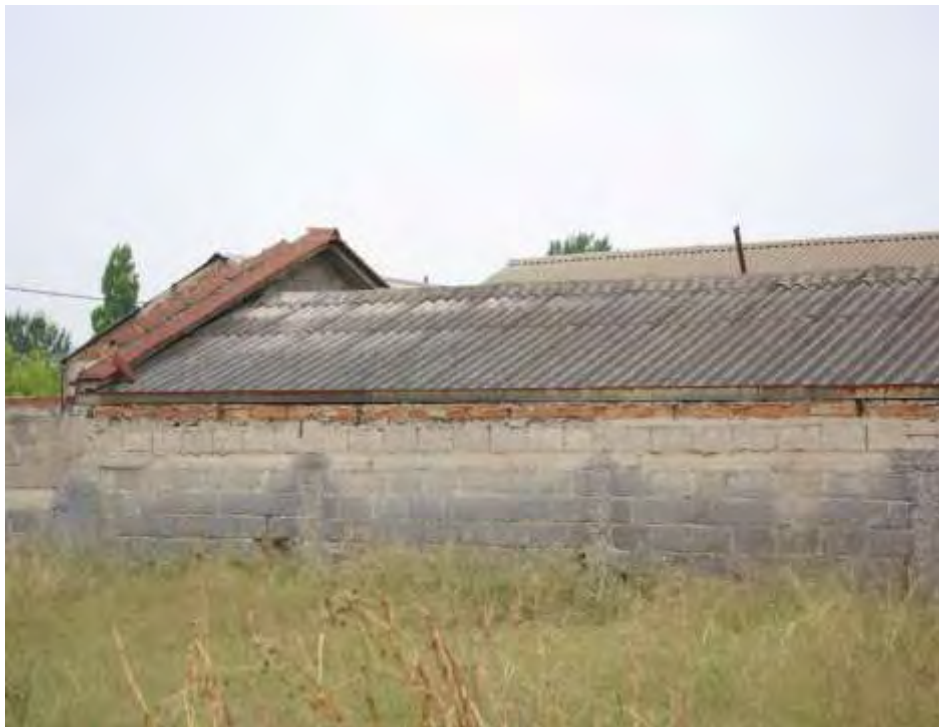
Εικόνα 4. Στέγη κτηρίου κατασκευασμένη από φύλλα αμιαντοτσιμέντου. (Πηγή: Προσωπικό αρχείο Δ. Πουρνάρα).
