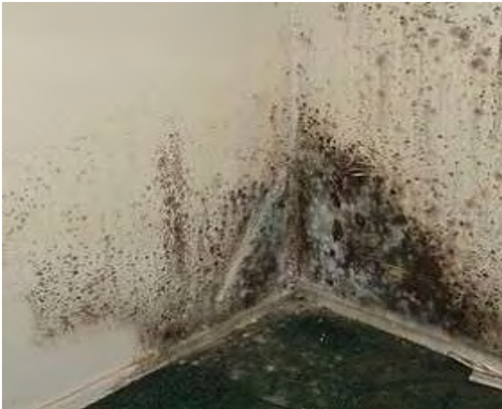
Εικόνα 8. Ανάπτυξη μούχλας σε γωνία δωματίου (Πηγή: AP Solutions and Resources Ltd. http://apsr.ca )
