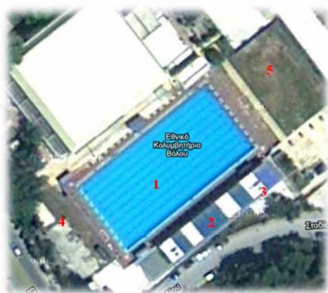
Εικόνα 2.2 Πανοραμική άποψη ανοικτού κολυμβητηρίου. (Χρήση προγράμματος Googlearth).
