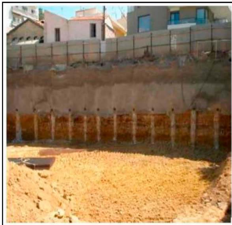
Σχήμα 2.1 Έγχυτοι φρεατοπάσσαλοι σε ασυνεχή διάταξη-Διάτρηση αγκυρίων, (Ζερβογιάννης, 2008)
