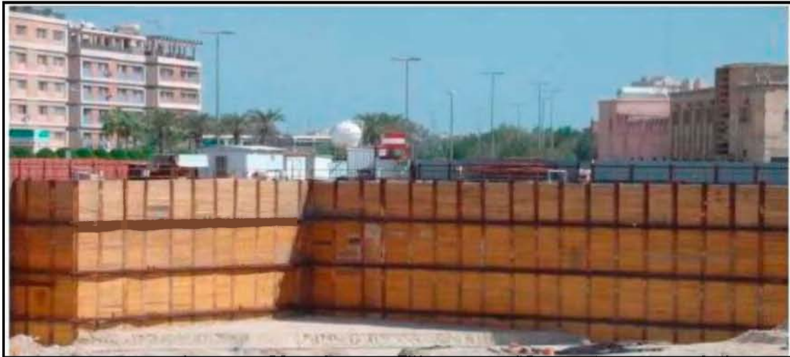
Σχήμα 2.6 Πέτασμα αντιστήριξης τύπου «Βερολίνου», (Ζερβογιάννης, 2008)
