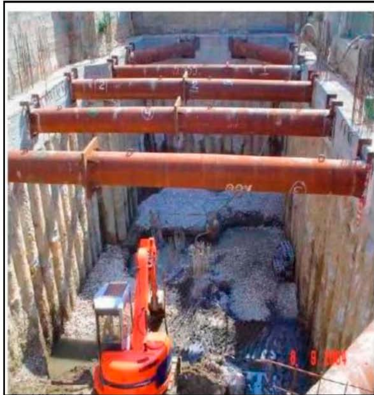
Σχήμα 2.2 Αλληλοτεμνόμενοι πάσσαλοι με μία σειρά μεταλλικών αντηρίδων, (Ζερβογιάννης, 2008)
