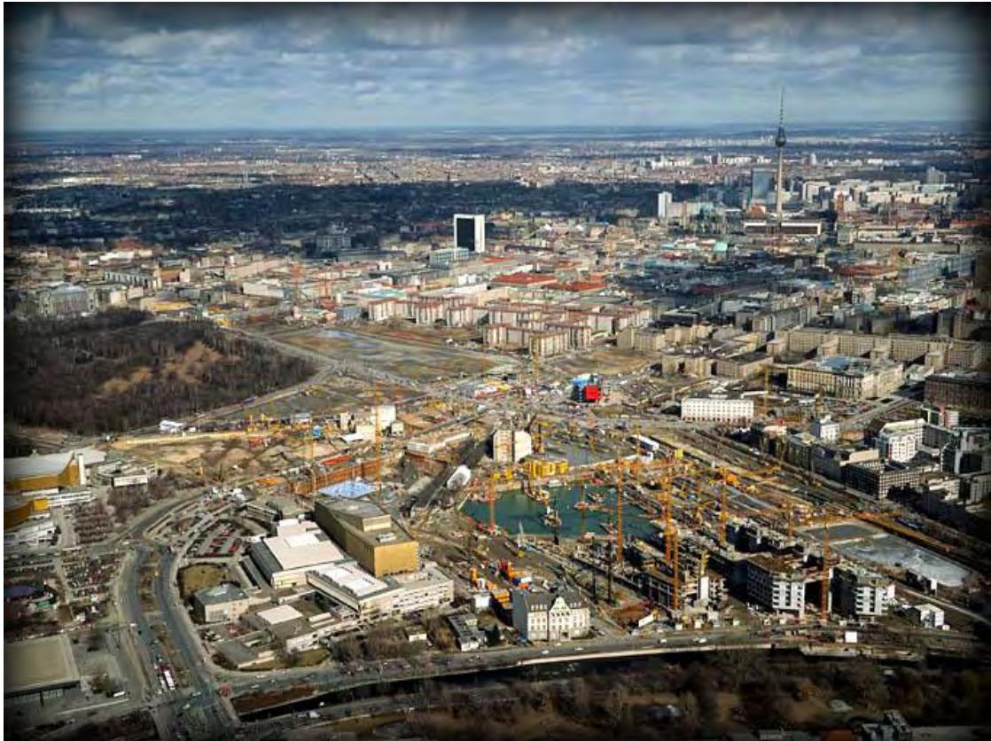
Εικόνα 4.7 Το κατασκευαστικό τοπίο της Potsdamer Platz, στα 1990.
