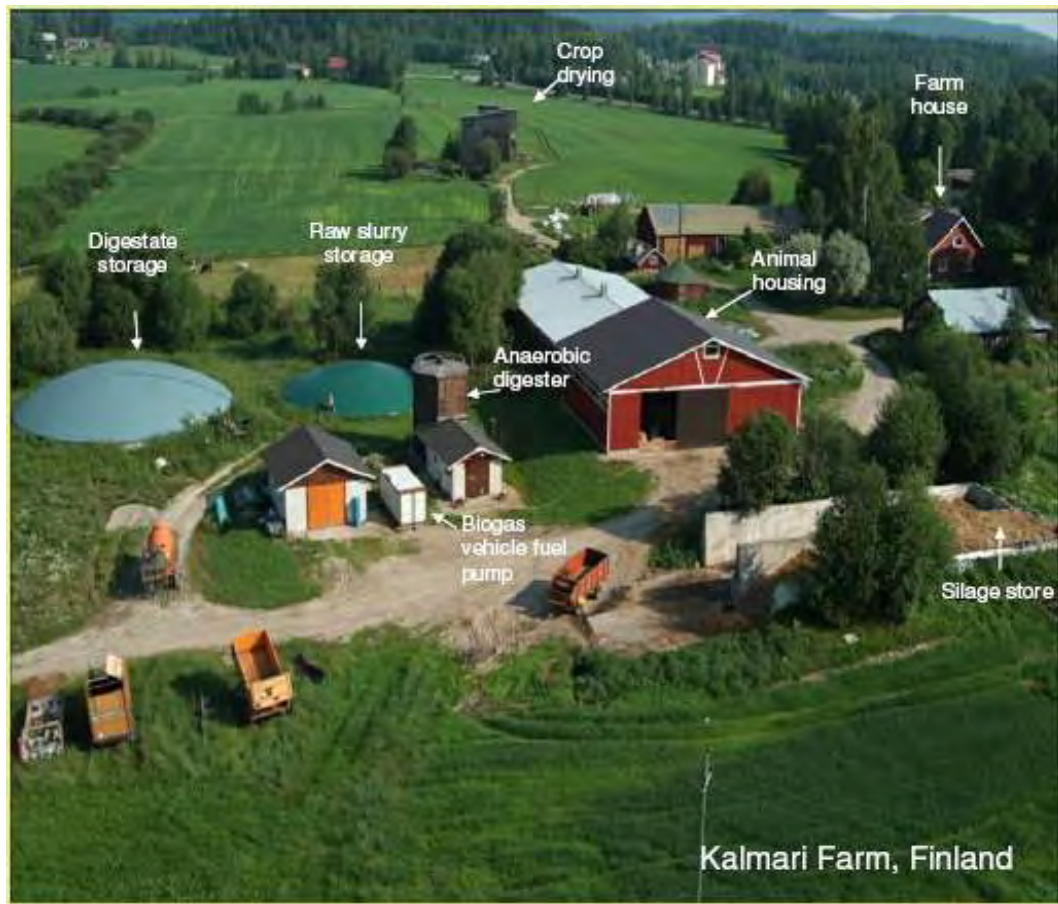
Εικόνα 4.2: Εγκατάσταση βιοαερίου κλίμακας αγροκτήματος στη Φιλανδία ( http://metener.webnode.com/biogas-plant-design/ )
