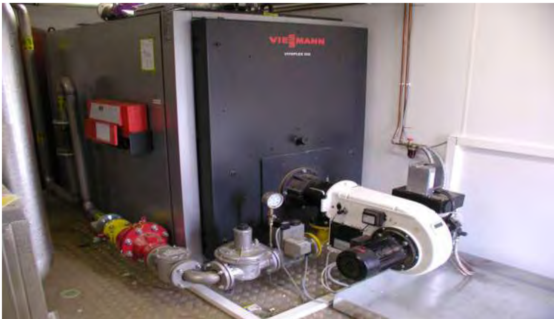
Εικόνα 3.1: Καυστήρας βιοαερίου για την παραγωγή θερμότητας ( www.biogas-plant.com )
