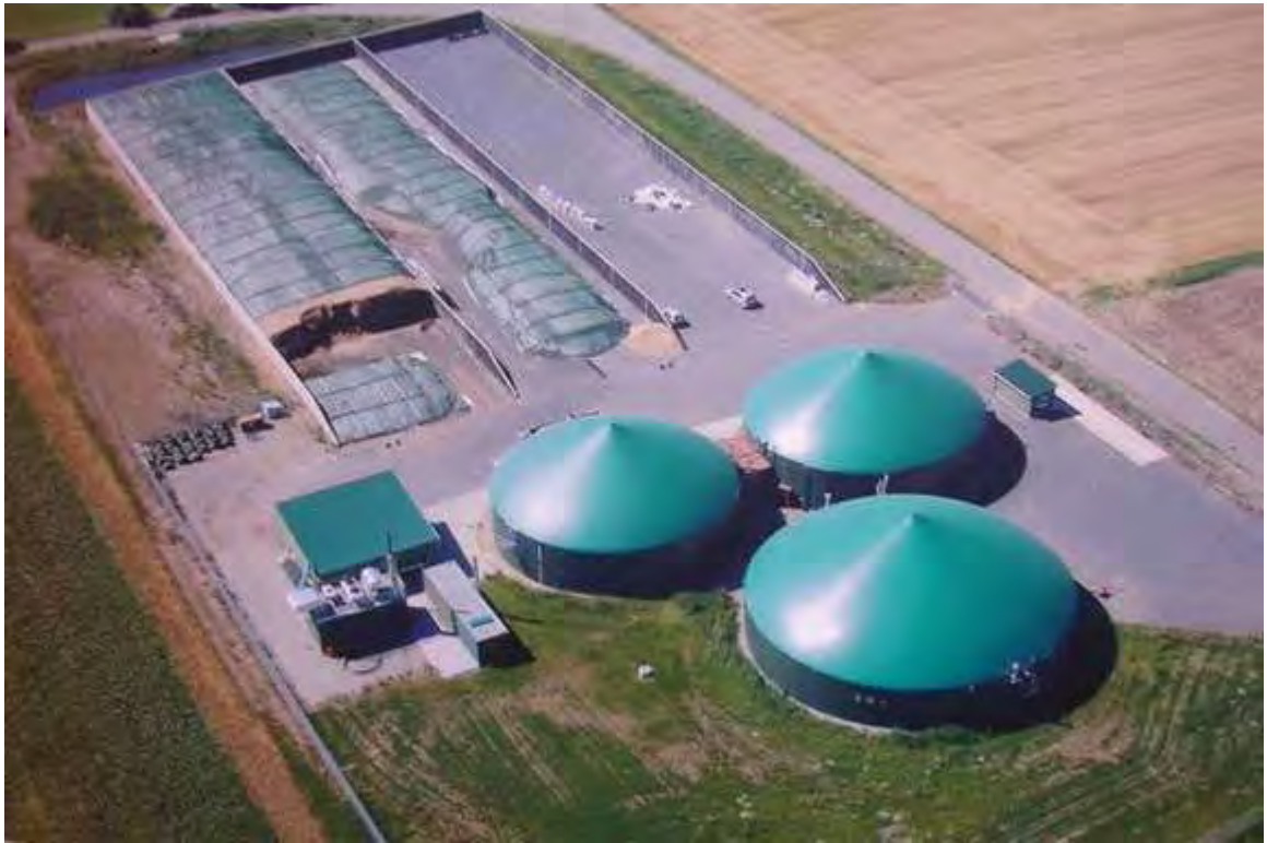
Εικόνα 4.3: Κοινή (Κεντρική) εγκατάσταση βιοαερίου στη Γερμανία ( www.tx.nrcs.usda.gov )
