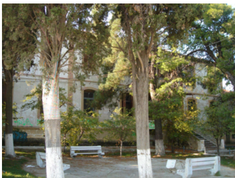
Εικ. 78: Κτίριο Διοίκησης Κ14.
