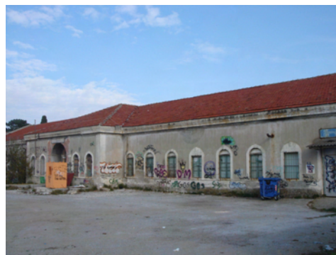
Εικ. 81 : Κτίριο Κέντρου Ψυχαγωγίας Μονάδας Κ18
