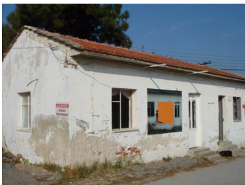
Εικ. 108: Κτίσμα Κ1, προτείνεται η μη κατεδάφισή του.
