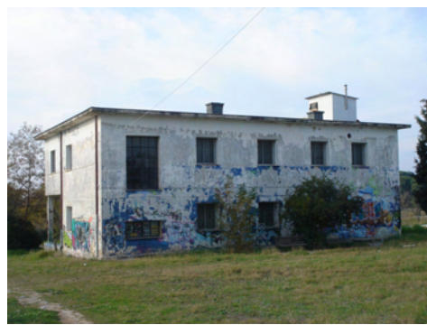
Εικ. 110: Κτίσμα Κ30, προτείνεται η μη κατεδάφισή του.
