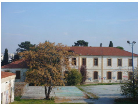
Εικ. 76: Κτίριο Διοίκησης Κ14.
