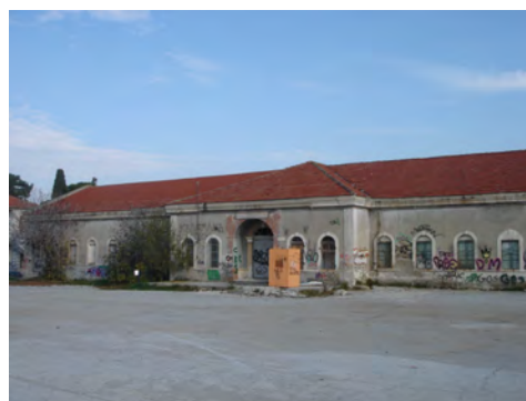
Εικ. 80: Κτίριο Κέντρου Ψυχαγωγίας Μονάδας Κ18.
