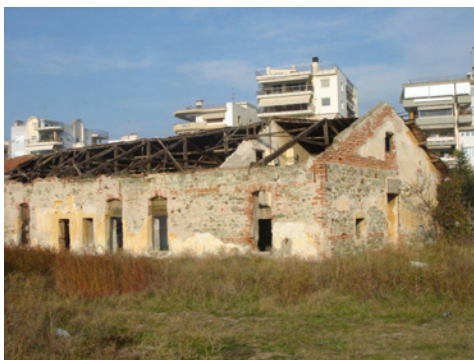
Εικ. 84: Κέλυφος κτιρίου Αποθηκών Κ7.
