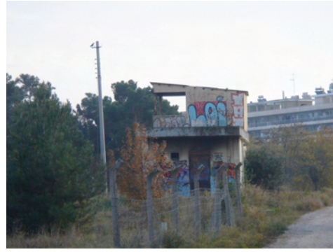
Εικ. 121: Κτίσμα K24, προτείνεται η κατεδάφισή του.
