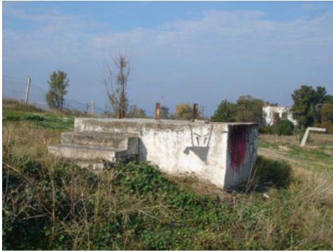
Εικ. 118: Κτίσμα K17, προτείνεται η κατεδάφισή του.
