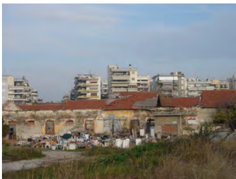
Εικ. 88 : Κέλυφος κτιρίου Αποθηκών Κ10.
