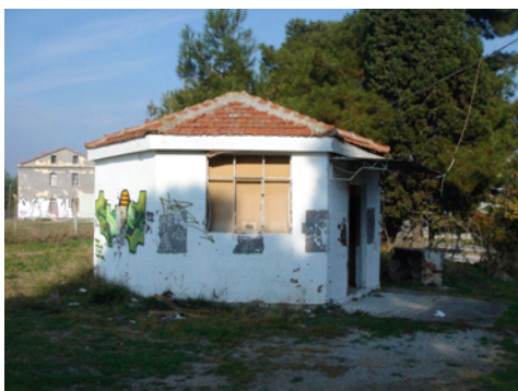
Εικ. 109: Κτίσμα Κ3, προτείνεται η μη κατεδάφισή του.
