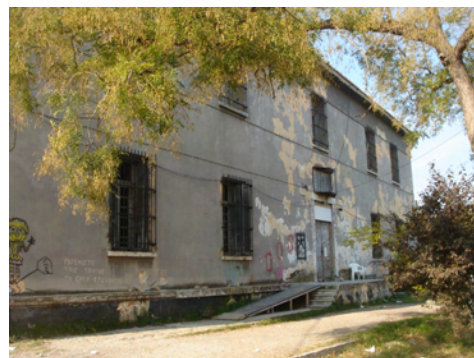
Εικ. 75: Κτίριο Στρατωνισμού Κ2.
