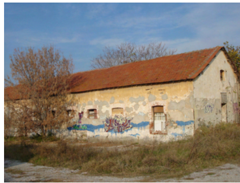
Εικ. 87: Κέλυφος κτιρίου Αποθηκών Κ9.
