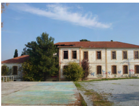
Εικ. 77: Κτίριο Διοίκησης Κ14.
