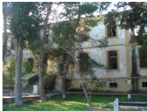
Εικ. 79: Κτίριο Διοίκησης Κ14.
