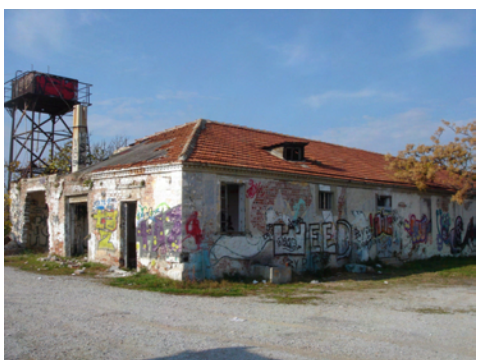
Εικ. 90 : Κτίριο Διαχείρισης και Αποθήκης Υλικού ΜΟΜΑ Κ16 (λήψη 2009).
