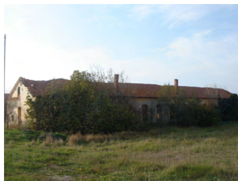
Εικ. 85: Κέλυφος κτιρίου Αποθηκών Κ7.
