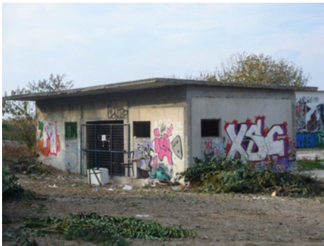
Εικ. 120: Κτίσμα K21, προτείνεται η κατεδάφισή του.
