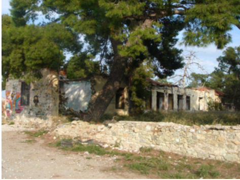
Εικ. 94: Κτίριο Διοικητικών Υπηρεσιών Κ23.
