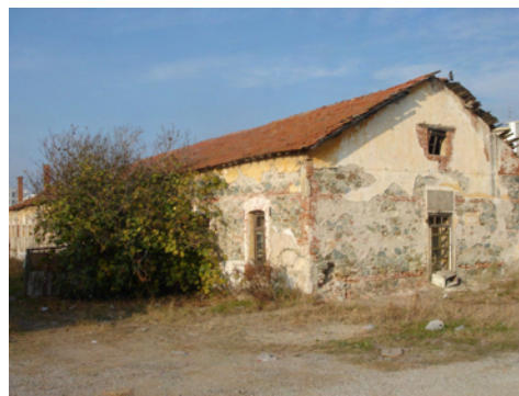
Εικ. 86: Κέλυφος κτιρίου Αποθηκών Κ8.
