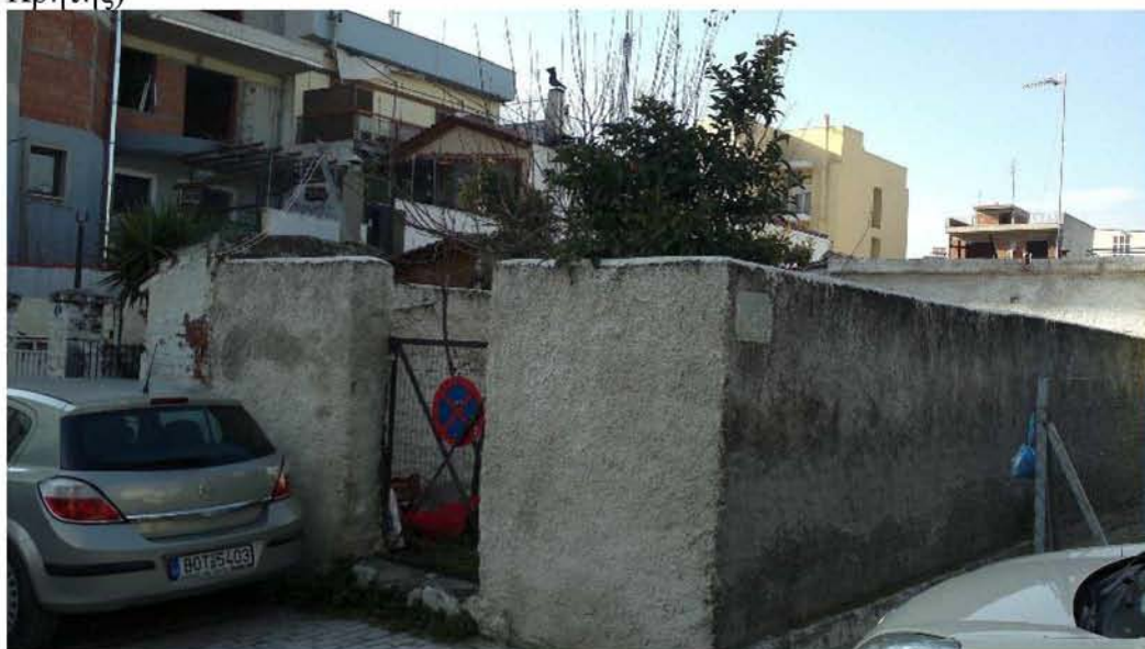
Χώρος δημιουργίας νέου χώρου στάθμευσης (Δημοκρατίας – Κρήτης)
