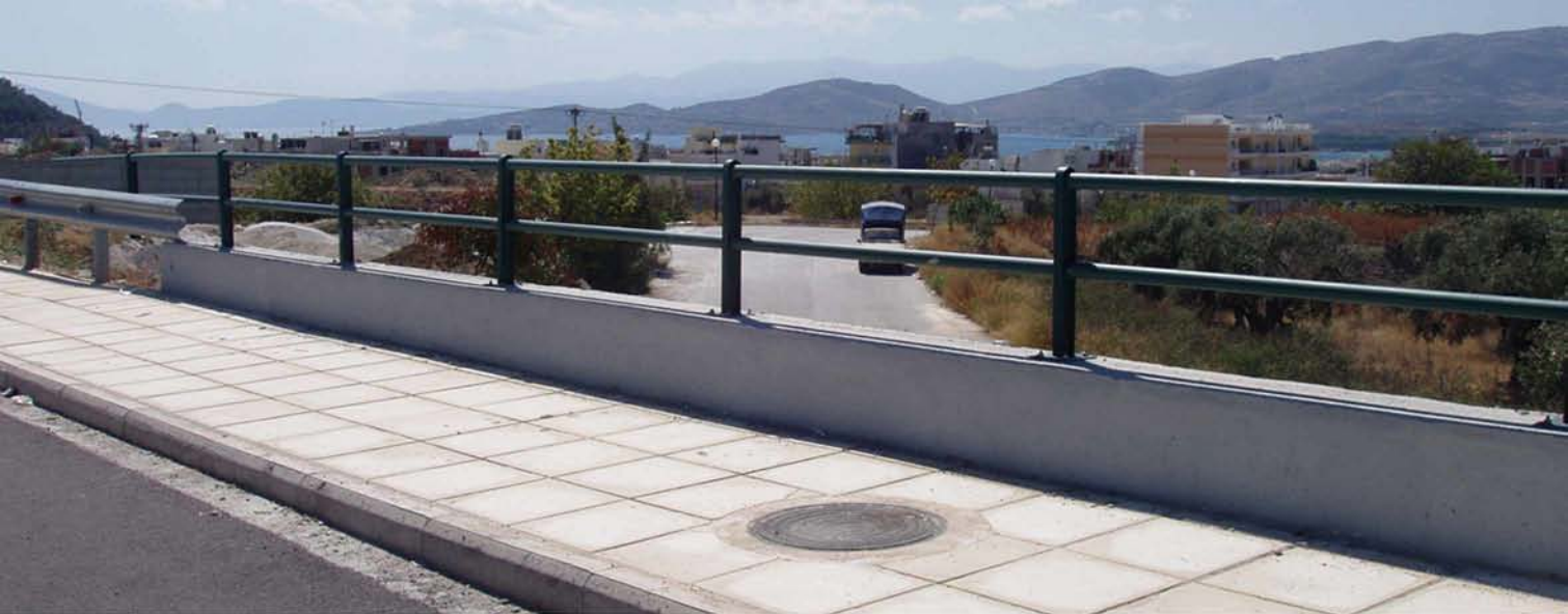
Φωτογραφική αποτύπωση υπάρχοντος χώρου επέμβασης πριν την έναρξη της κατασκευής
