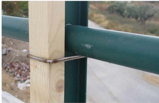
Λεπτομέρειες στήριξης των κολωνών στο κάγκελο και τοποθέτησης του παραβόπανου μέσω του μηχανισμού του "χριτς-χρατς"
