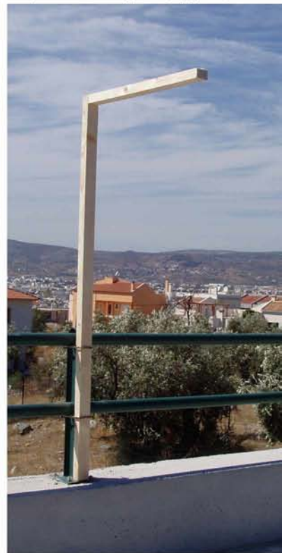
Λεπτομέρειες στήριξης των κολωνών στο κάγκελο και τοποθέτησης του παραβόπανου μέσω του μηχανισμού του "χριτς-χρατς"
