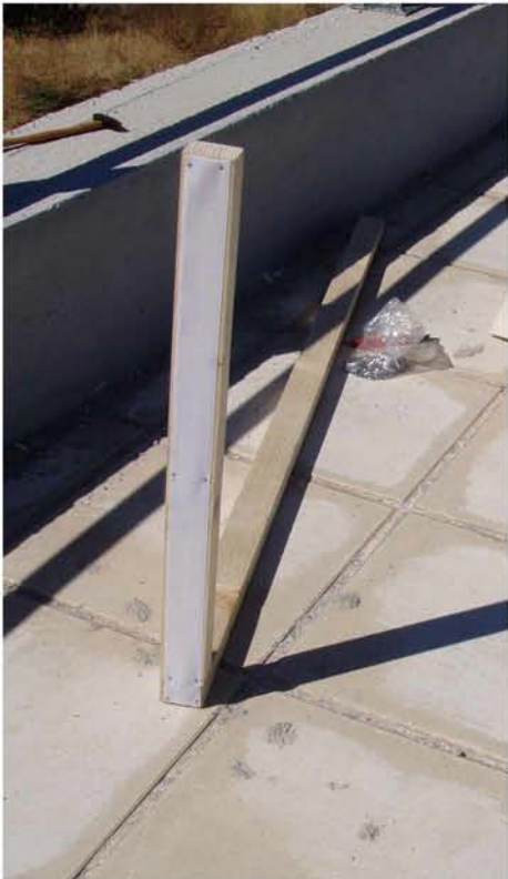
Λεπτομέρειες στήριξης των κολωνών στο κάγκελο και τοποθέτησης του παραβόπανου μέσω του μηχανισμού του "χριτς-χρατς"
