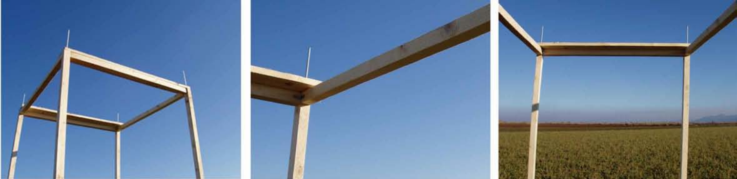
Λεπτομέρειες του τρόπου τοποθέτησης της οροφής
