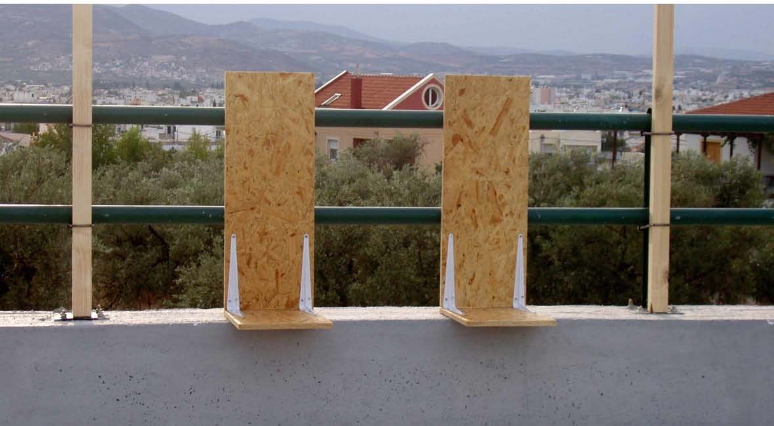
Λεπτομέρεια κατασκευής και τοποθέτησης της καρέκλας στήσης
