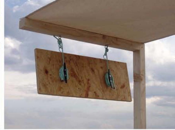
Λεπτομέρεια λειτουργίας του караβόποανου ως μεταβαλλόμενου στεγάστρου
