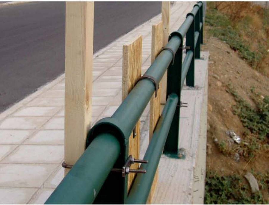
Λεπτομέρεια κατασκευής και τοποθέτησης της καρέκλας στήσης
