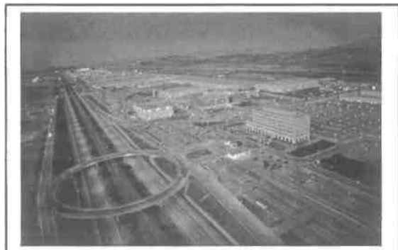
Εικ. 10: Αεροδρόμιο Ελευθέριος Βενιζέλος -- Σύνδεση προς το κτίριο κεντρικού αεροσταθμού
