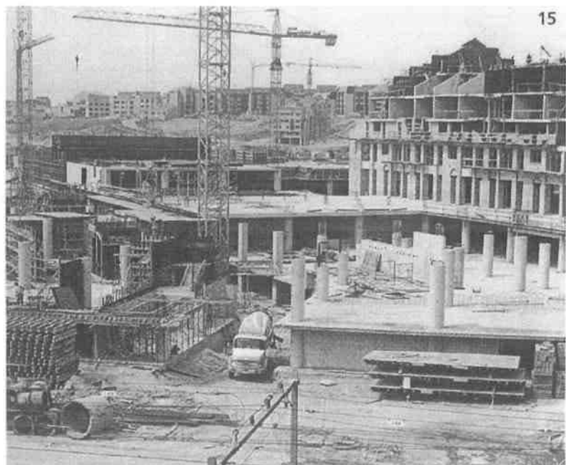
Εικόνα 3.5 : « Εικόνα από την κατασκευή της τσιμεντένιας πλάκας (dalle) που διατρέχει το κέντρο.»
