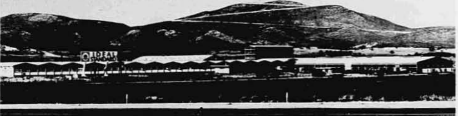
Γενική έξωτερική άποψη των διοργανικών εγκαταστάσεων της 'Ιντελ Στάνταρντ, παρά τη Ριτώνα Βοιωτίας όπου παραδεδω τα είδη υγιεινής 'Ιντελ Στάνταρντ και τα προϊόντα από πλαστικό. Στο άκρο δεξίω, το νέο 'Εργοστάσιο παραγωγής αργιλλοπορφυρικών πυρμαχών της 'Εταιρίας 'Ιντελ Στάνταρντ - Πυρμαχών Α.Β.Ε.
