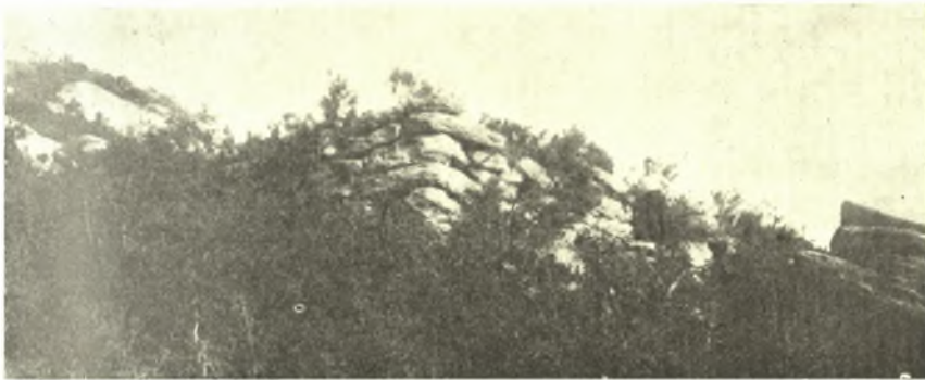
Εἰκ. 1. Ἀνατολικὸς τετράπλευρος πύργος τῆς Οἰσύμης.
