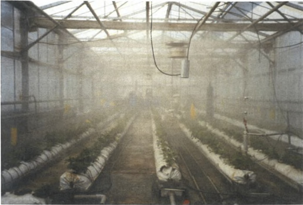
Εικόνα 16. Αποψη του εσωτερικού του θερμοκηπίου με το σύστημα δροσισμού σε λειτουργία.
