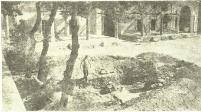
Εἰκ. 5. Ἡ ἐκσκαφὴ εἰς τὸ βόρ. τμήμα τοῦ τοίχου εἰς τὸ προαύλιον τοῦ ναοῦ.
