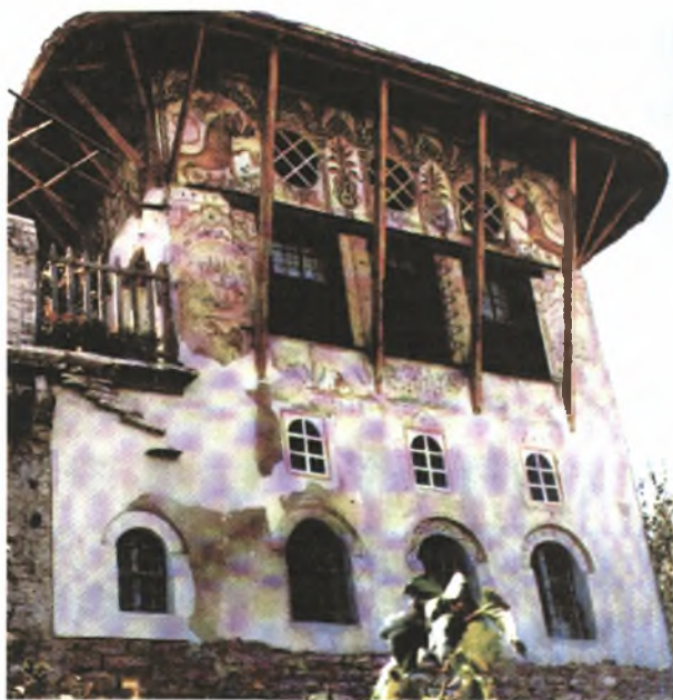
Πρόγραμμα ζωγραφικής διακόσμησης προσόψεων κοσμικού κτιρίου στο Αργυρόκαστρο 273
