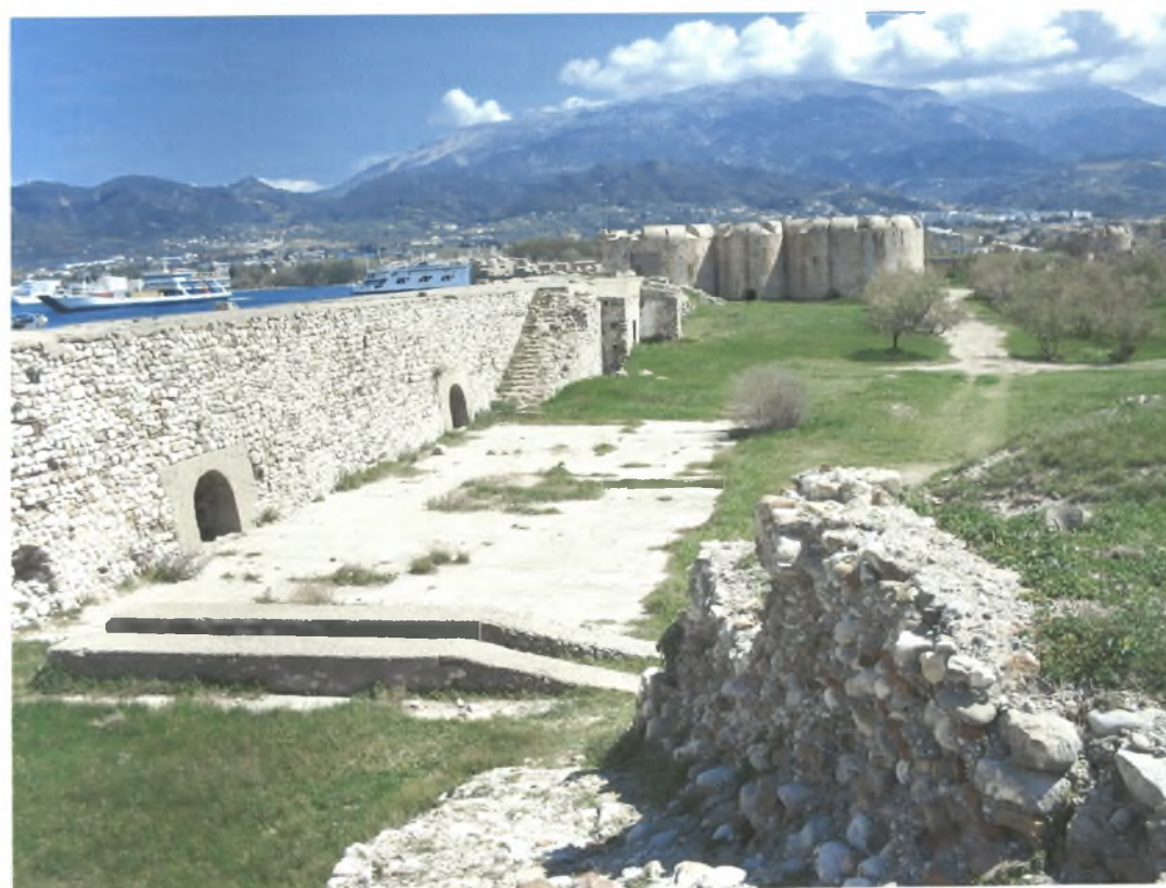
Εικ. 67: Ρίον. Τμήμα Ανατολικού Ενετικού τείχους με κλίμακα για τον περίδρομο και εισόδους σηράγγων.
