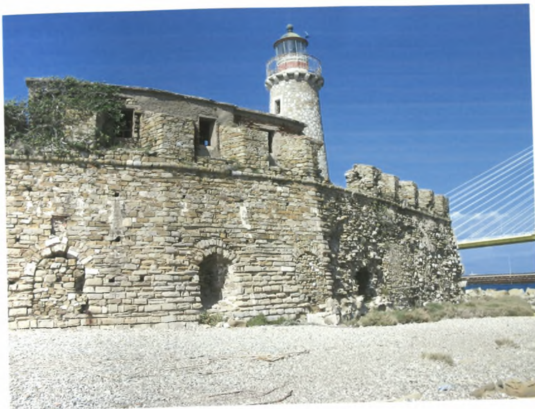
Εικ. 87 Αντίρριο Νότιο εξωτερικό τμήμα κάστρου
