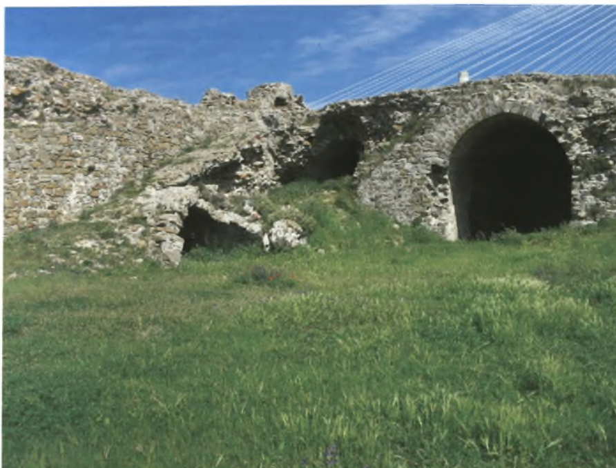
Εικ. 93 Αντίρριο ΒΑ Εξαγωνικός πύργος από το εσωτερικό
