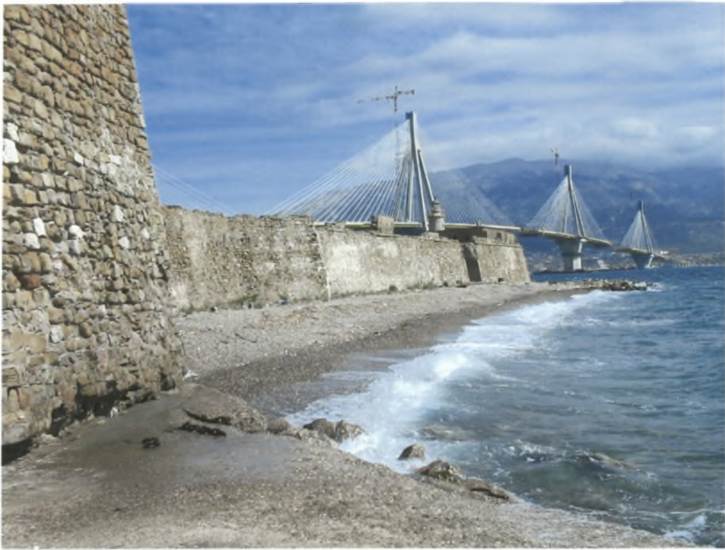
Εικ. 81 Αντίρριο Ρομβοειδής μικρός προμαχώνας στο δυτικό τείχος
