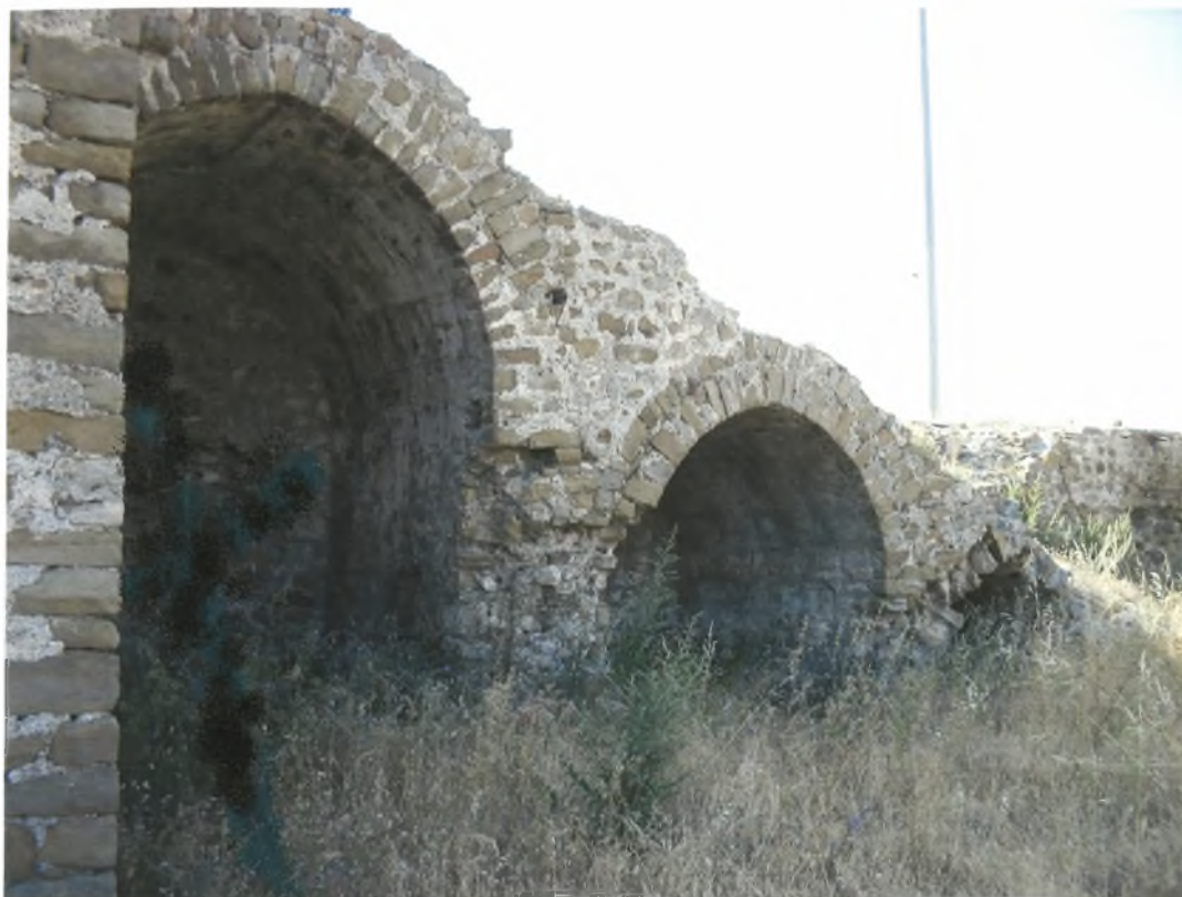
Εικ. 79 Αντίρριο Κεκλιμένο επίπεδο ανεβάζει στις επάλξεις του ΒΔ τείχους
