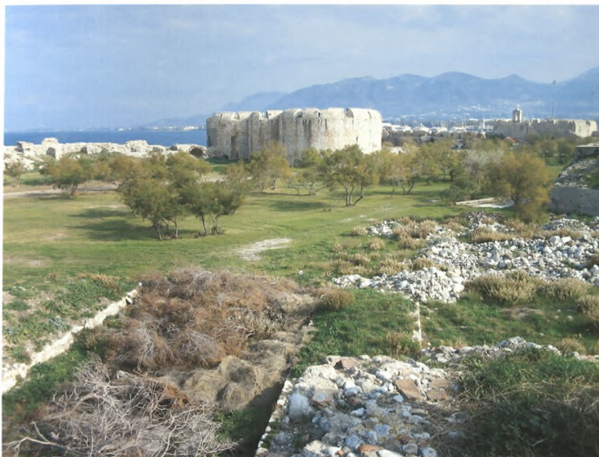
Εικ. 68 Ρίον. Άποψη του εσωτερικού φρουρίου από το ΒΔ τείχος.
