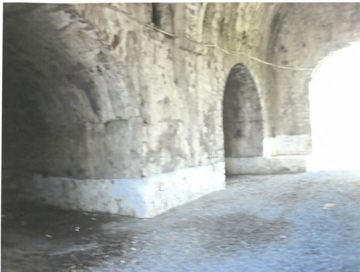
Εικ. 75 Αντίρριο Ο εσωτερικός διάδρομος του οχυρού της εισόδου.
