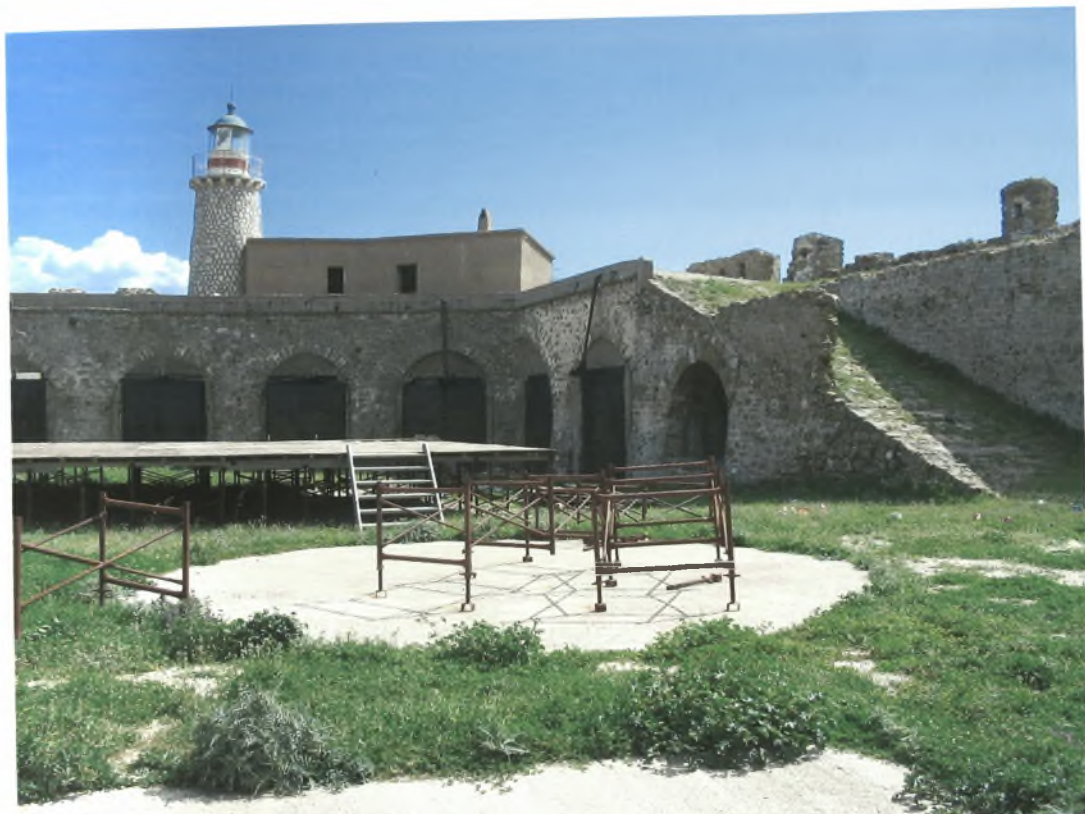
Εικ. 85 Αντίρριο Αψιδωτές αίθουσες νότιου τμήματος.
