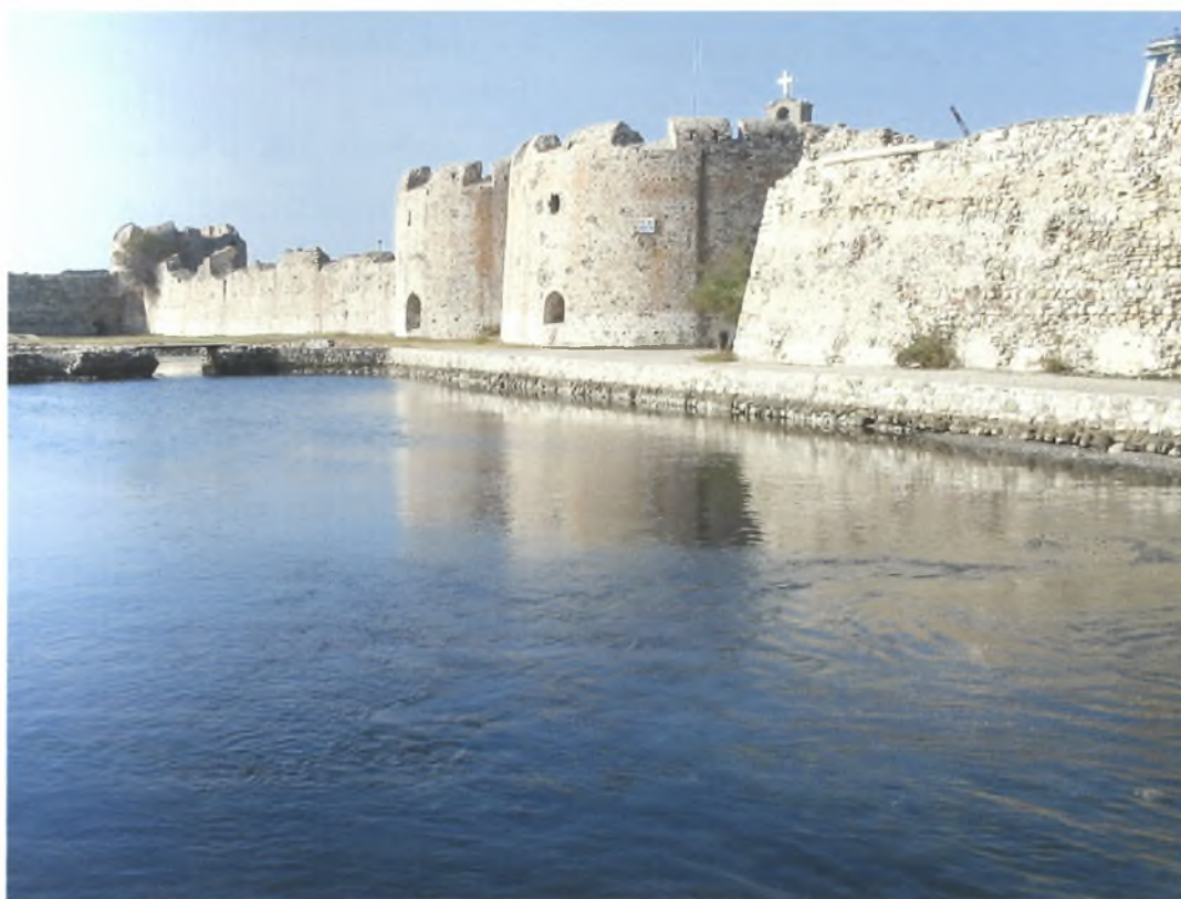
Εικ. 50: Ρίον. Οθωμανικό οχυρό: Οι κεντρικοί πύργοι της Νότιας πλευράς από την τάφρο
