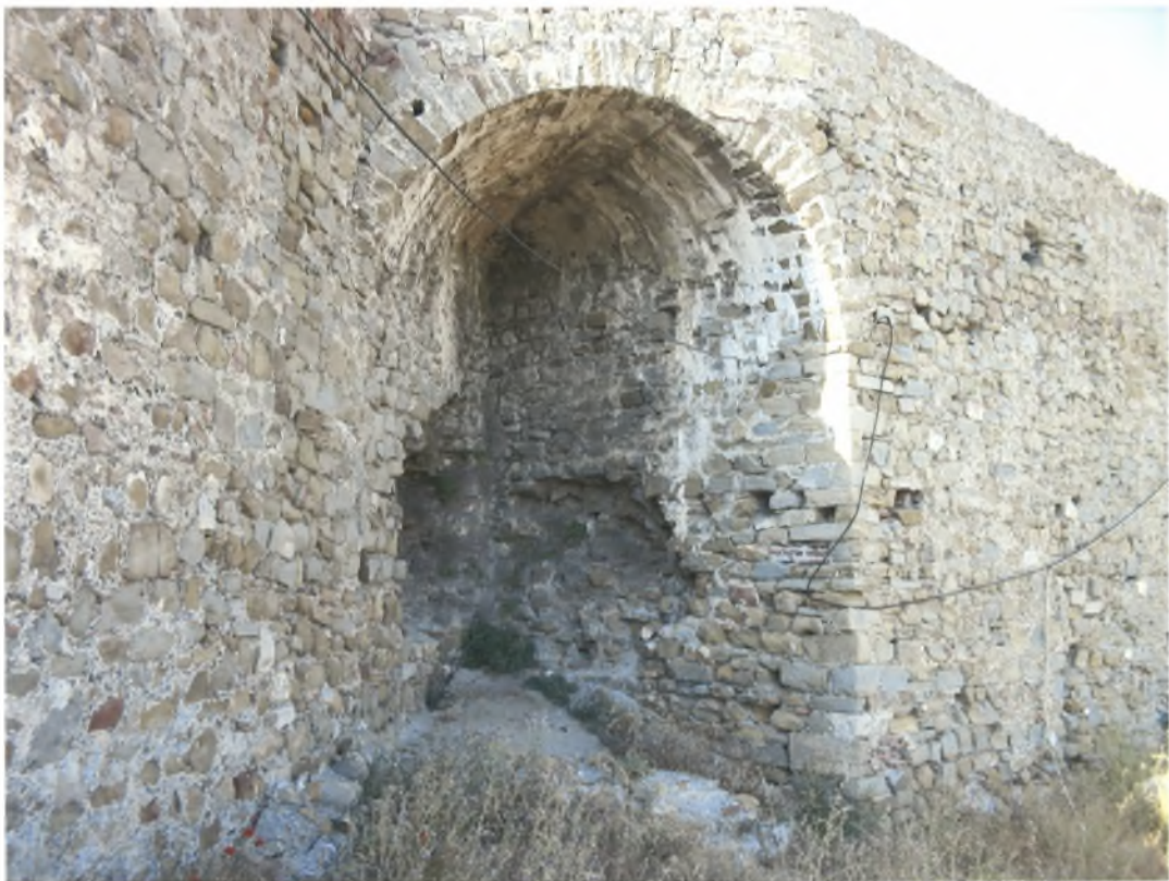
Εικ. 78 Αντίρριο ΒΔ πλευρά του οχυρού της εισόδου από το εσωτερικό του κάστρου
