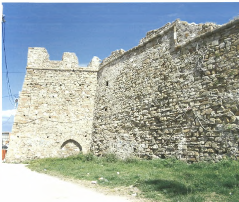
Εικ. 74 Αντίρριο ΒΔ κανονιοθυρίδα οχυρού εισόδου, κλίση τείχους και διακοσμητικό κυμάτιο
