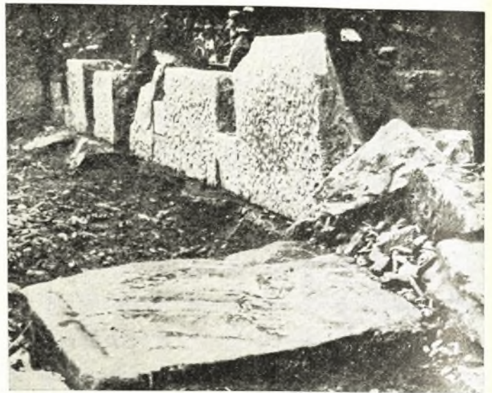
Λείψανα βορείου τοίχου ἀρχαίου κτηρίου τῆς Σκοπέλου.
