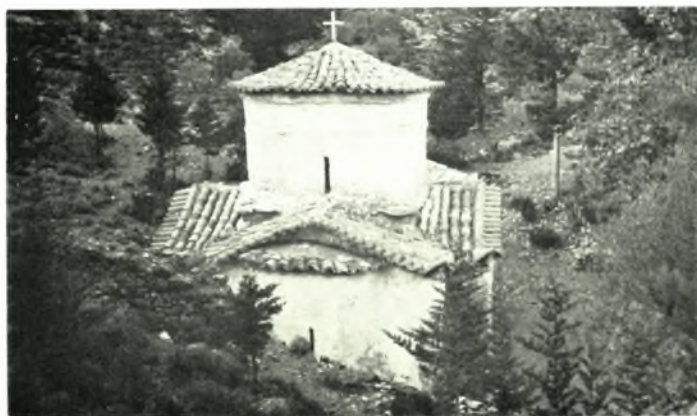
Ἄρκαδια-Μεσσηνία: α. Ὁ παρά τὸ Λεβίδι ναὸς τῆς Κοιμήσεως μετὰ τὰς προσφύτους ἐργασίας, β. Ὁ ἐν Δυρραχίῳ Ἄρκαδιας ναὸς τῆς Ῥεκίτζας κατὰ τὴν διάρκειαν τῶν ἐργασιῶν συντηρήσεως, γ. Ὁ ναὸς τοῦ Προδρόμου τῆς ἐν Ἄρτεμισίᾳ Μονῆς Μελέ
