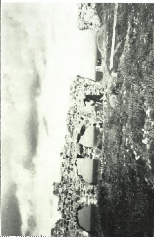
Μυτιλήνη. Κάστρον : α - β. Χαίνον τμήμα τοῦ ἀνατολικοῦ τείχους πρὸ καὶ μετὰ τὴν στέρεωσιν αὐτοῦ, γ. Στέρεωσις κανονισσασιῶν ΒΑ. πλευρᾶς, δ. Ὁ Μεντρεσῆς ἐπισκευαζόμενος
