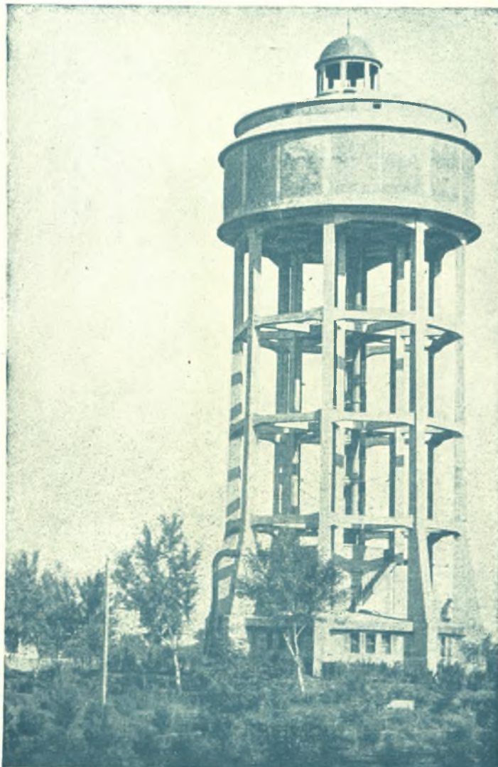
Λάρισα : 'Ο πύργος ύδρευσης και καθαρισμού του ύδατος
