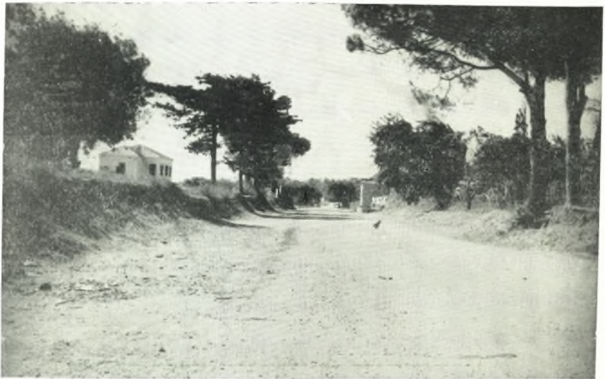
α. Ἡ κατασκευασθεῖσα νέα ὁδός, ὀλίγον στενωτέρα τῆς ὑπ' αὐτὴν ἀρχαίας.
