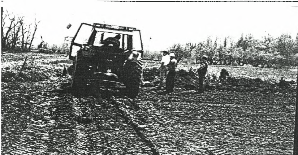
Εικόνα 5.1. Τοποθέτηση υποεπιφανειακού σταλακτηφόρου σωλήνα
