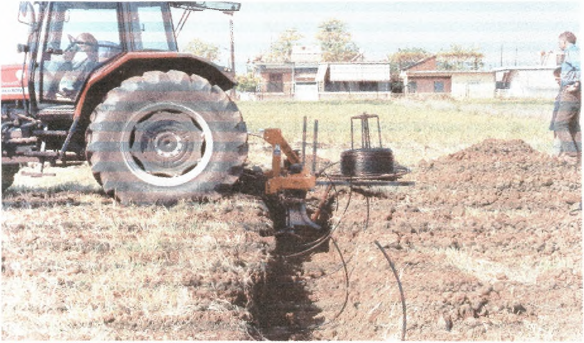
Εικόνα 9. Τοποθέτηση υπόγειας στάγδην άρδευσης
