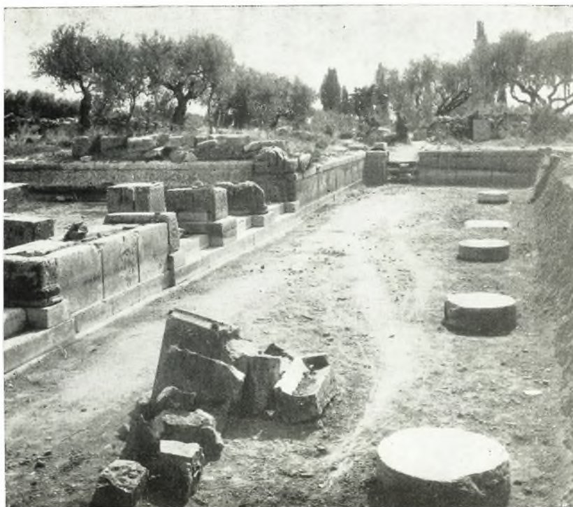
α. Οί ἀποκαλυφθέντες κατώτατοι σφόνδυλοι τῆς ἀνατολικῆς στοᾶς τῆς Ἀγορᾶς τῆς Μεσσήνης. Ὅψις ἀπὸ Βορρᾶ.
