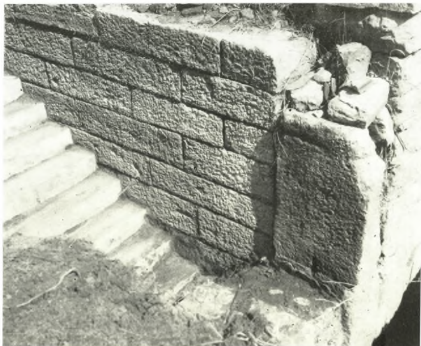
β. Όψις τοῦ ἀνατολικοῦ τμήματος τῆς μνημειώδους κλίμακας.
