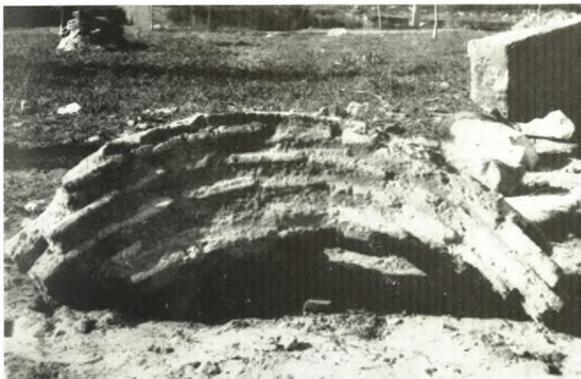
α. Τμήμα πλινθοδομῆς ἐκ τῆς κορυφῆς τῆς θόλου τοῦ κακλικοῦ παρὰ τὴν κόγχην κτίσματος.
