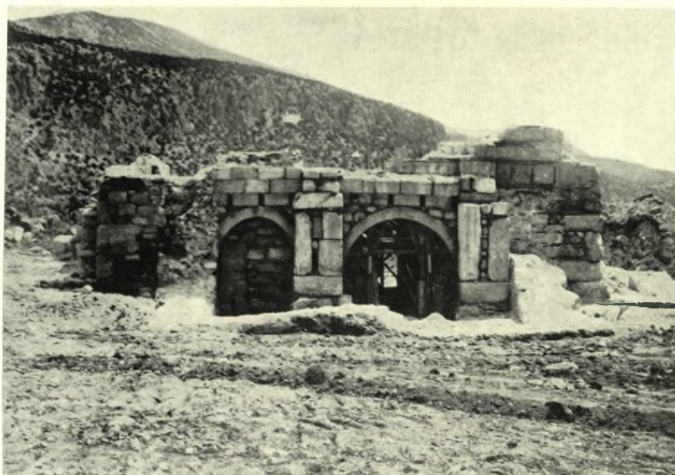
Ἀντίκυρα: α. Τὰ ἐρείπια τοῦ ἀποκαλυφθέντος εἰς σχῆμα σταυροῦ Πύργου ἀπὸ Β., β. Τὸ κτίσμα ἀπὸ Β. μετὰ τὴν διάλυσιν τῆς βορείου κεραίας τοῦ Πύργου
