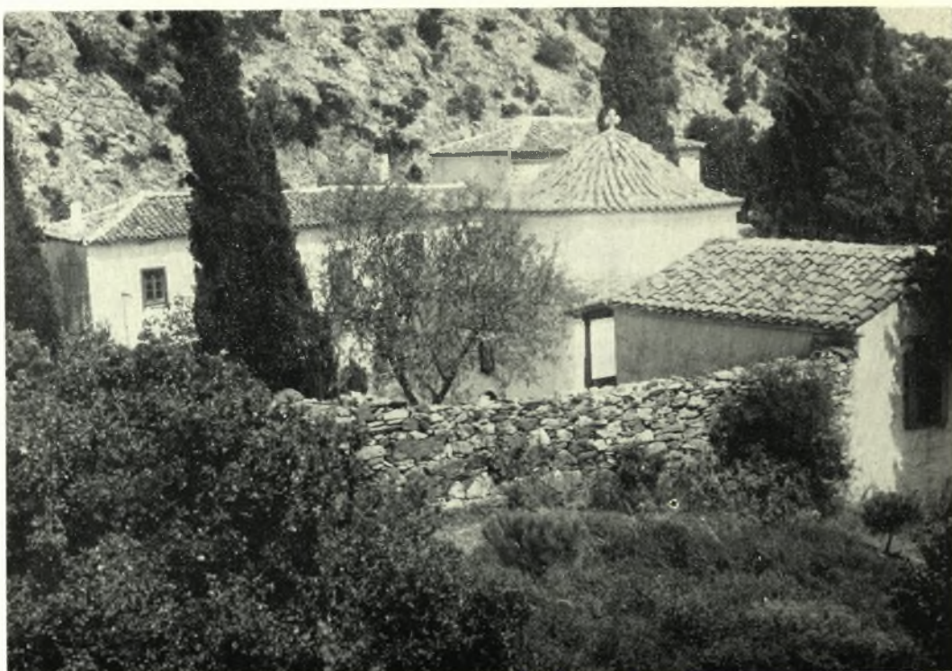
Σκίαθος: α. Ήρειπωμένα κελλία τῆς μονῆς τοῦ Εὐαγγελισμοῦ, β. Ἐποψὶς τῆς μονῆς τοῦ Ἁγίου Χαραλάμους
