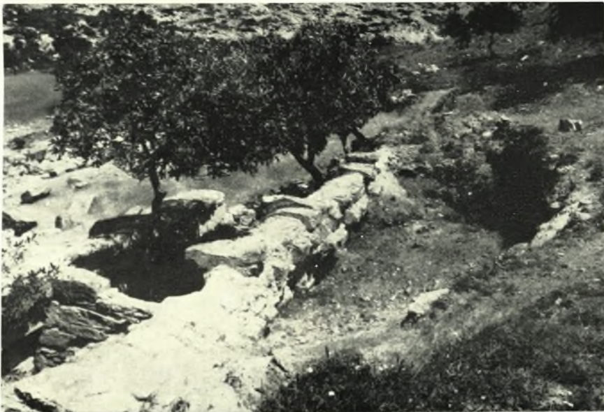
Ptoion. a. Kastraki: Nettoyage général au début des travaux, b. Perdicovrysi. Les Réservoirs vue arrière à la fin du nettoyage
