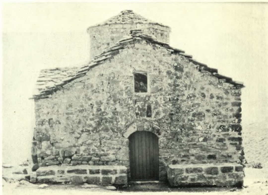
Ἄχαῖα. Δραγάνον: α - β. Ὁ βυζαντινὸς ναὸς τοῦ Ἁγίου Δημητρίου Μπάδα πρὸ καὶ μετὰ τὰς ἐργασίας στερεώσεως
