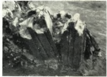
β. Τμῆμα καταπεσόντος τόξου.
