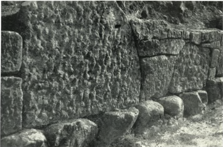
β. Λεπτομέρεια κατασκευῆς τείχους τῆς Ἀμφιπόλεως.
