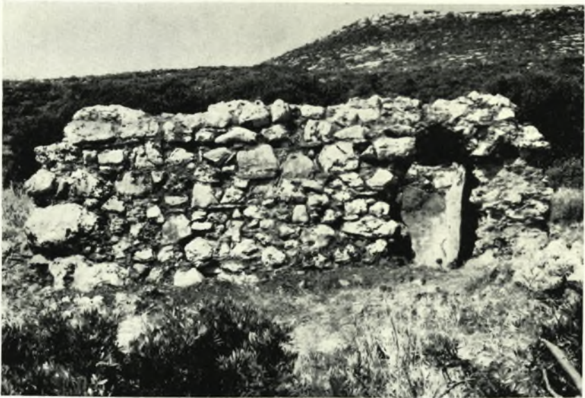
α. Ὑπέργειος δεξαμενή εἰς Λυκοτόμαρον Μεθώνης. Ἐποψὶς ἀπὸ Α.
