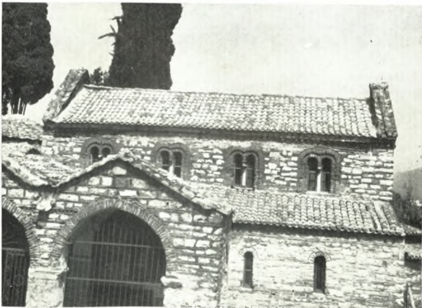
β. Ἡ νέα κατασκευασθεῖσα στέγη τῆς Ἁγ. Θεοδόρας.
