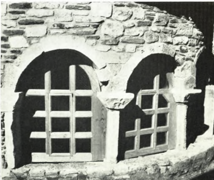
β. Τό τρίλοβον παράθυρον της άψίδος του 'Αγ. Νικολάου' μετά τās εργασίας αποκαταστάσεως αυτού.
