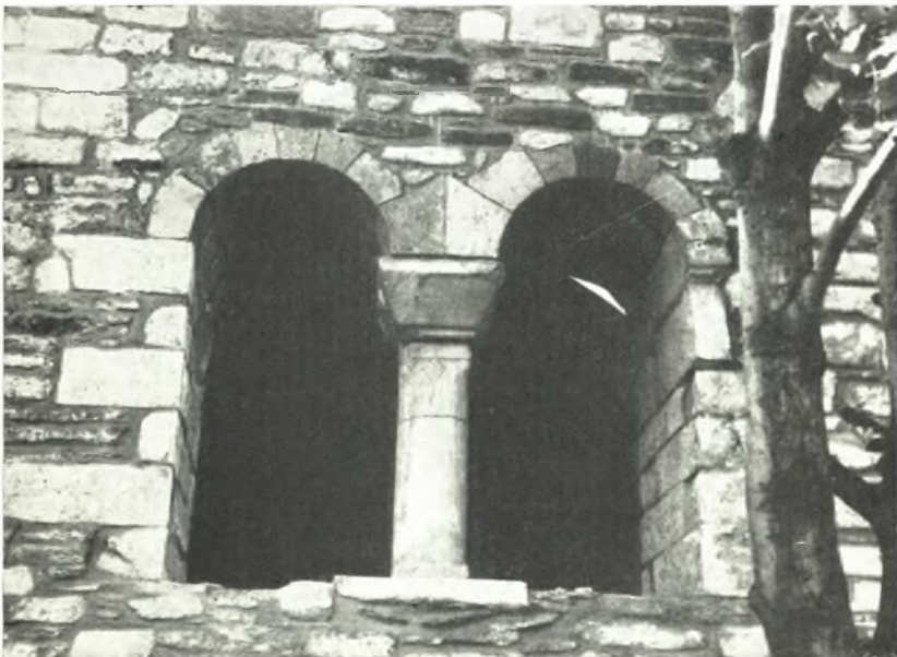
β. Τὸ ἀνοιχθὲν κατὰ τὴν βόρειον πλευρὰν τοῦ Ἁγ. Νικολάου δίλοβον παράθυρον μετὰ τὰς ἐργασίας ἀποκαταστάσεως αὐτοῦ.
