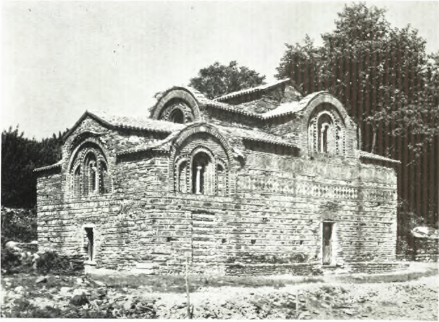
α. Ἐξωτερικὴ τῆς Κόκκινης Ἐκκλησίας ἀπὸ Ν.Α. μετὰ τὰς ἐργασίας στερεώσεως αὐτῆς.
