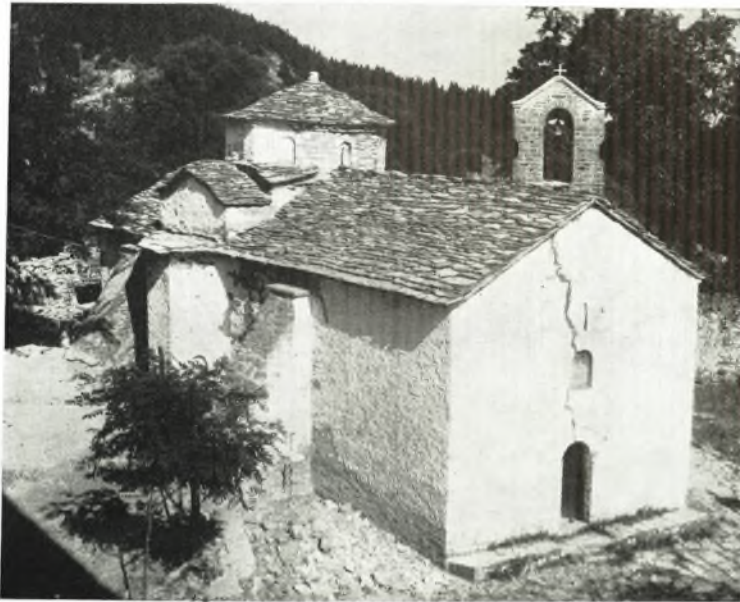
α. Ὁ ναός τοῦ Ἁγ. Γεωργίου πρὸ τῶν ἐργασιῶν στερεώσεως αὐτοῦ.
