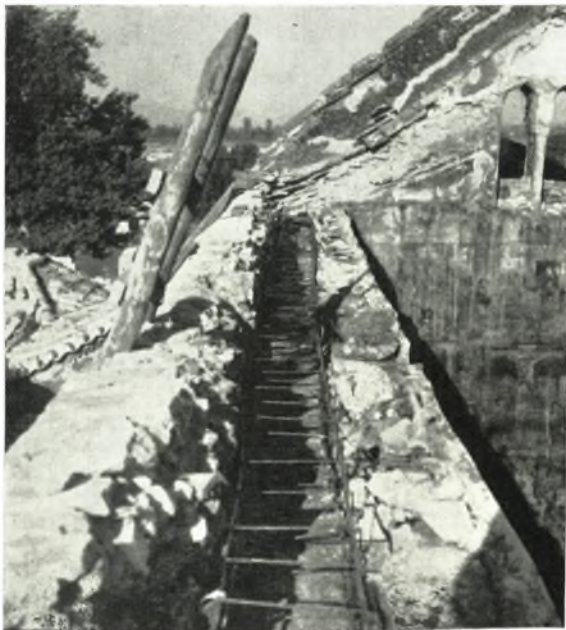
β. Ἡ ἐξ ὀπλισμένου σκυροδέματος δοκὸς στηρίξεως τῆς νέας στέγης τῆς Ἁγ. Θεοδώρας.
