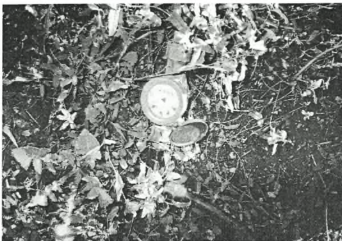
Εικόνα 5.18. Υδρόμετρο.
