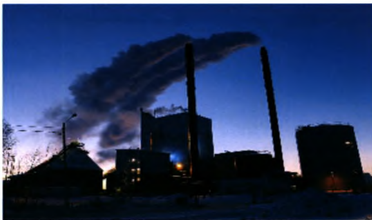
Εικόνα 7:Εργοστάσιο τηλεθέρμανσης στην Φινλανδία
