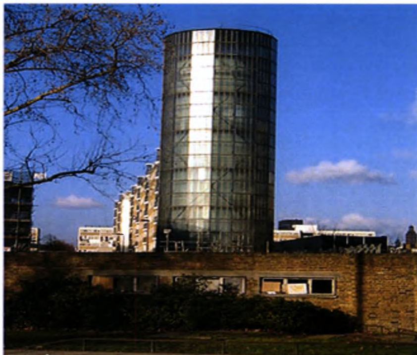
Εικόνα 17:Συσσωρευτής στο Pimlico District Heating Undertaking
