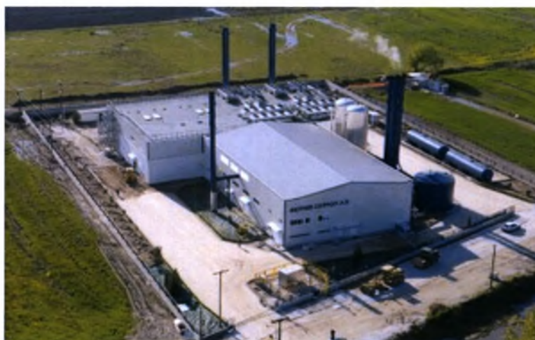
Εικόνα 21:Εργοστάσιο φυσικού αερίου στις Σέρρες
