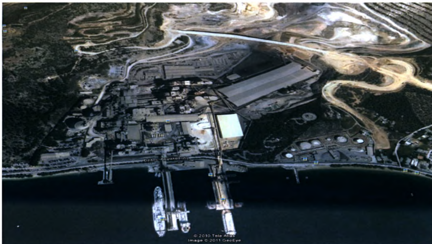
Εικόνα 30: Φωτογραφία από τις εγκαταστάσεις ΑΓΕΤ Ηρακλής στον Βόλο(από το Google Earth)
