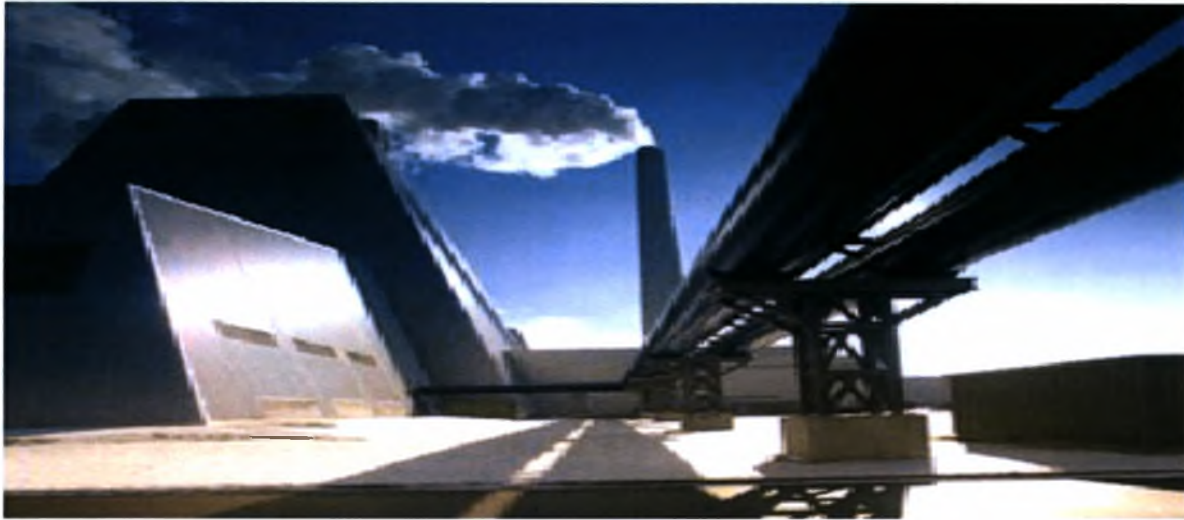
Εικόνα 5: Εργοστάσιο αποτέφρωσης καυσίμων με τηλεθέρμανση στην Κοπεγχάγη
